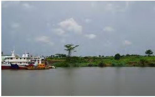
写真-25 コンテナターミナル岸壁計画位置 左手樹木付近が新規コンテナバース西端
