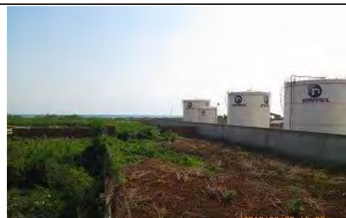
写真-30 港湾用地境界現況 隣接する油槽所との境界は右手のフェンス
