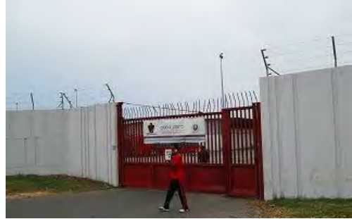
写真-10 港湾入りロゲート現況 ゲートに”Global Port Services Burundi”の文字
