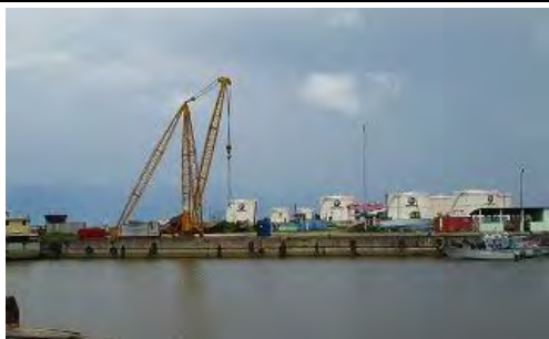
写真-7 既存「コンテナバース」現況 油槽所の石油タンクが見える
