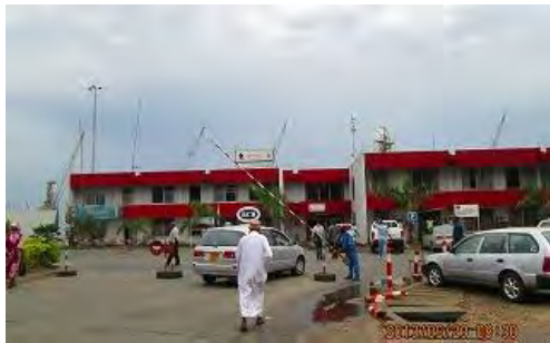
写真-21 管理棟外観現況
