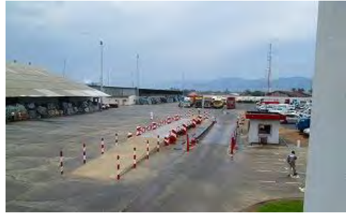
写真-12 トラックスケール全容 全ての貨物車と国境通過車両の重量を計測
