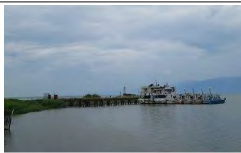
写真-4 南側防波堤と軍棧橋現況 南側防波堤は棧橋の向こう側
