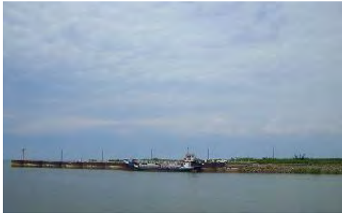
写真-9 オイルバース状況 (2009年) 北防波堤をオイルバースとして利用
