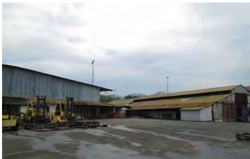
写真-23 ブジュンブラ港の修理工場
