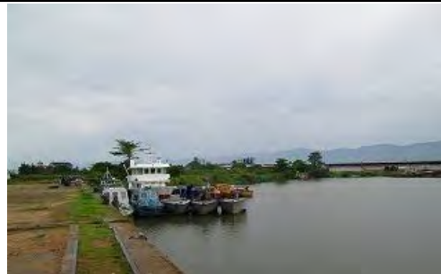
写真-8 既存「コンテナバース」現況 観光・調査船などの小型船が係留している
