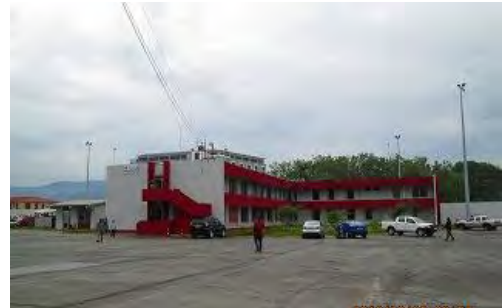
写真-22 管理棟外観現況
