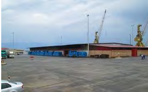
写真-19 第4倉庫外観 (パーキングエリア側)
