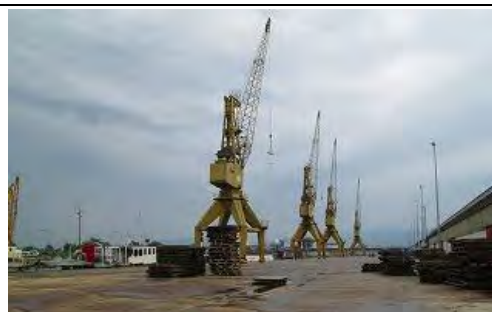
写真-6 一般貨物埠頭現況 埠頭の東端から見た一般貨物埠頭
