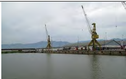
写真-5 一般貨物埠頭岸壁現況 対岸から見た一般貨物埠頭
