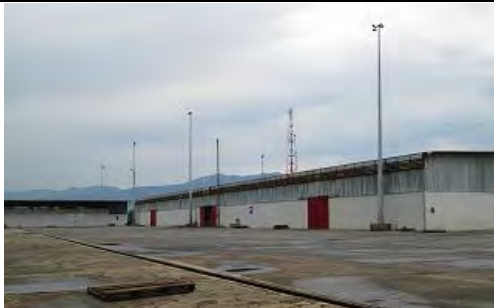
写真-15 第2倉庫外観 一般貨物が取り扱われる
