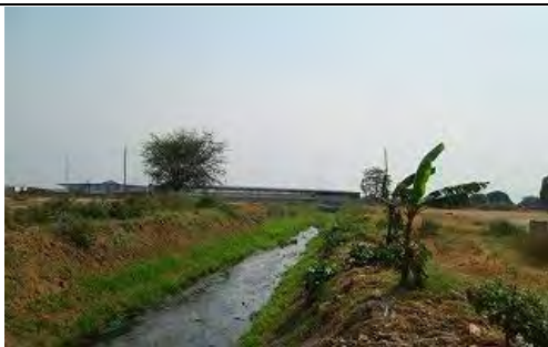
写真-31 ブェンジ排水路現況 保税フェンス外港湾用地を通る
