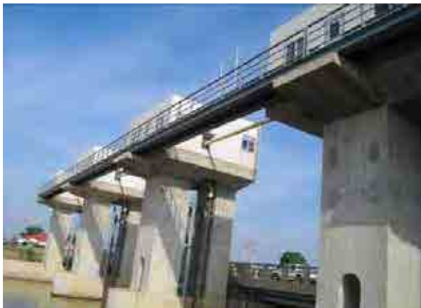
カンダール州の頭首工
