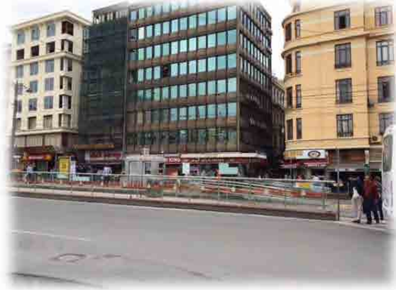
Şekil 3.19 Tramvay Sirkeci İstasyonu
