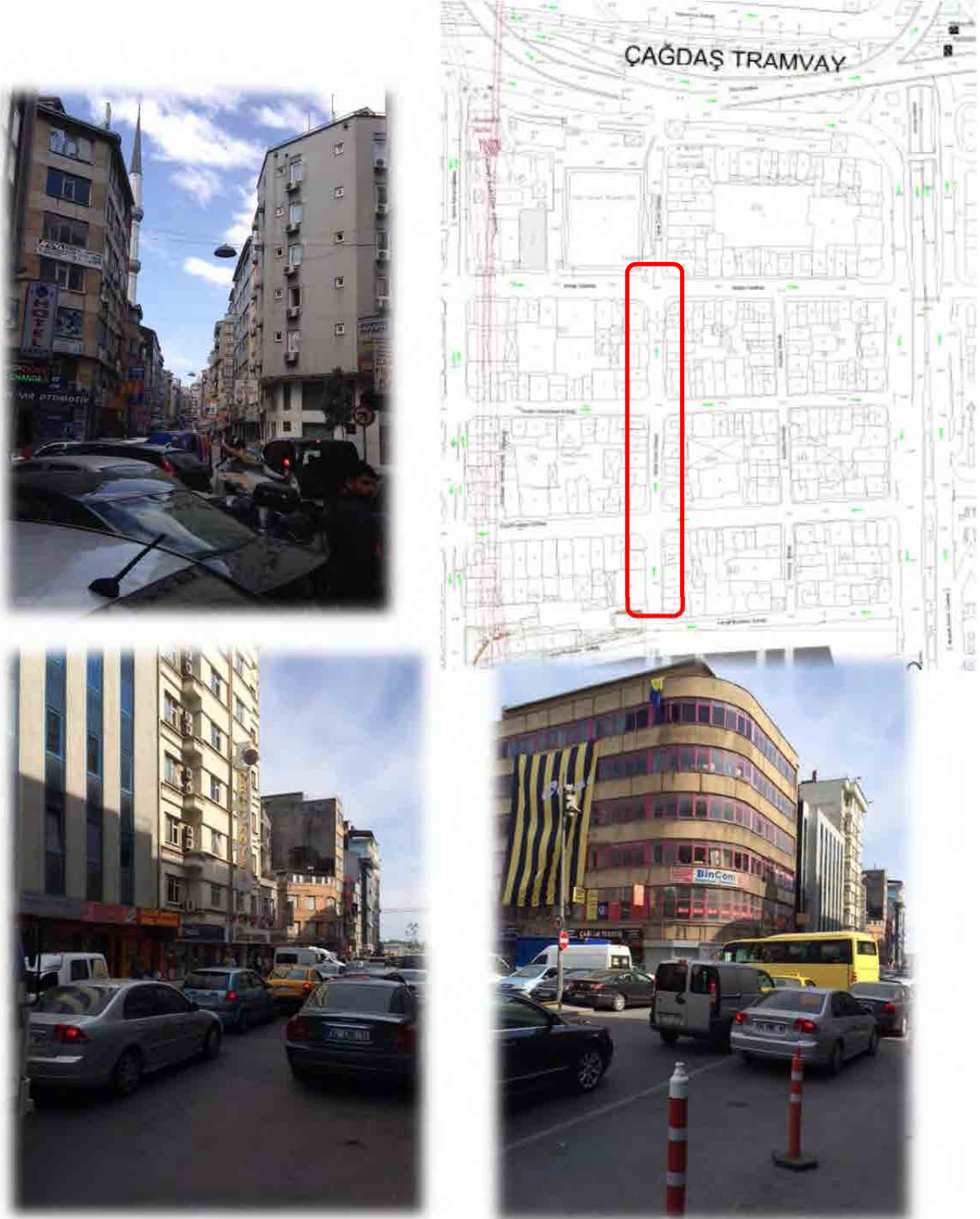
Şekil 3.29 Tıkanmış Yol ve Kavşak
