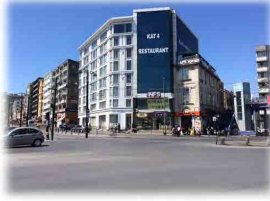
Şekil 3.20 Yeniden Yapılan Bina
