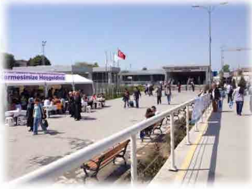
Marmaray Yenikapı İstasyonu
