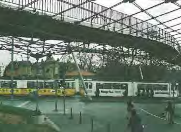
Şekil 3.70 Yaya Köprüsü Örneği (ALMANYA, Stuttgart)
