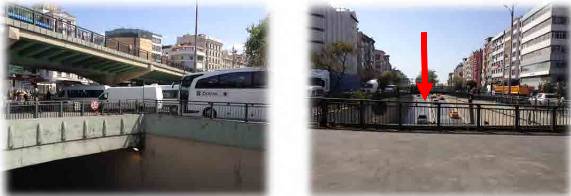
Şekil 3.9 Tramvay Aksaray İstasyonu Çevresinde Altgeçit ve Yaya Köprüsü
