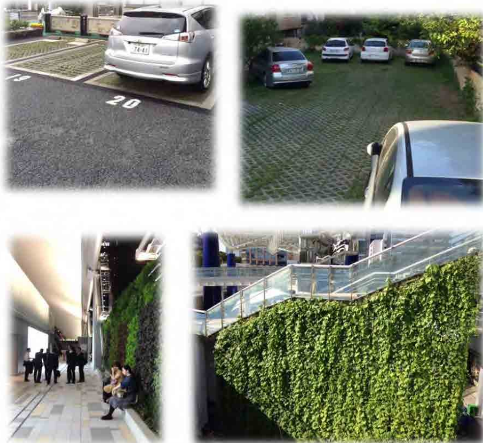
図 3.55 環境に配慮した施工事例
