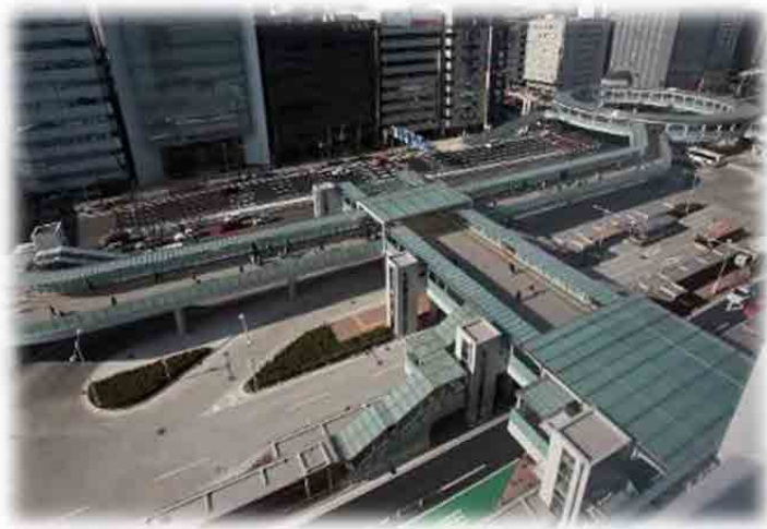
図 3.72 歩行者専用道路橋の事例（JAPAN, Shinyokohma station）
