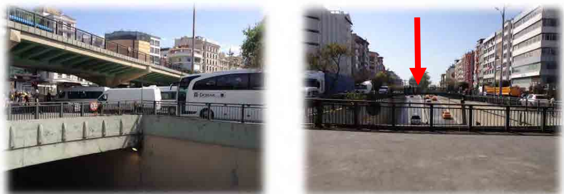
図 3.9 Aksaray Tram 駅付近のアンダーパス道路と横断するためのデッキ(右写真の奥)
