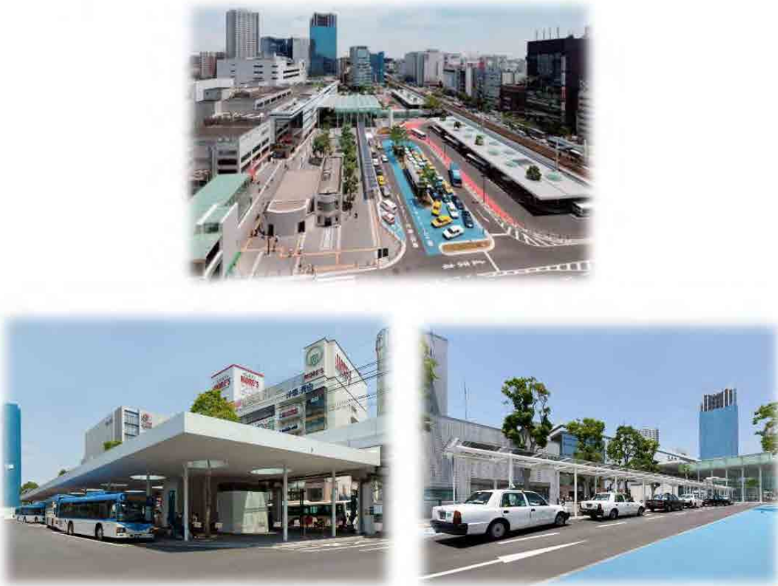
図 3.51 バスとタクシーの停留所を分離した駅の広場(神奈川県、川崎市)
