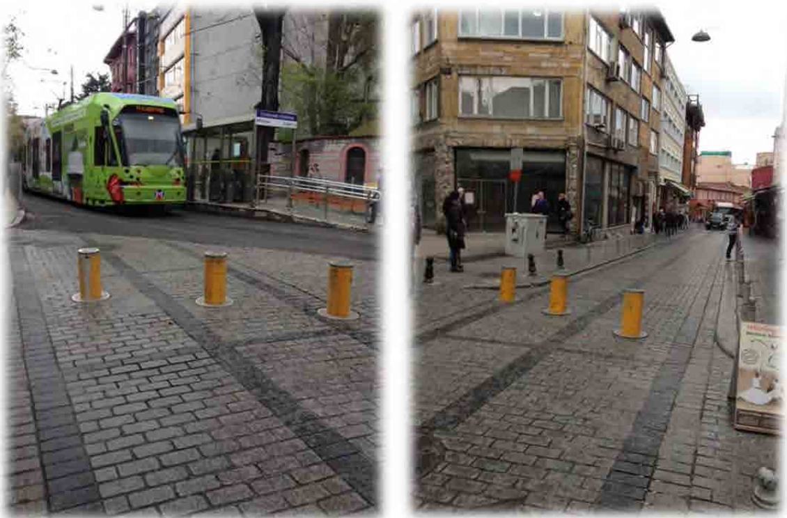
図 3.31 街中にある車乗入れ規制のためのライジング・ボラード
