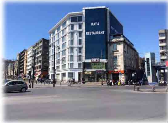
図 3.20 リニューアル中の建物
