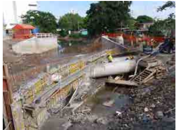
対策として、下水道の整備が急ピッチで進められている。
