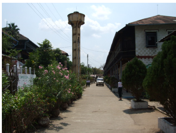
No. 3 現在のタウンゲーEC。中央道路の左右に管理部門、教室、学生寮等の木軸構造建物が近接し配置され、防災上危険な環境にある。
