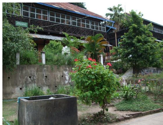
No. 4 現在のタウンゲーEC。高台にある木軸構造で築 60 年程度の教室棟(1 階が教室、2 階が学生寮)で、建物全体で老朽化が著しい。
