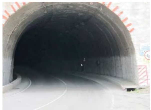
写真 2-5-7 トンネル No.2 内状況
