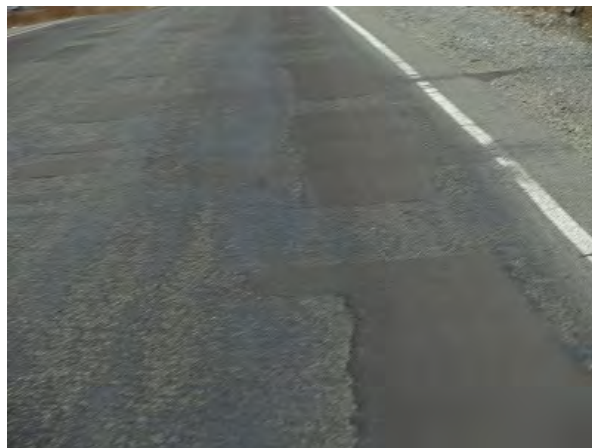
写真 2-5-1 舗装補修状況
