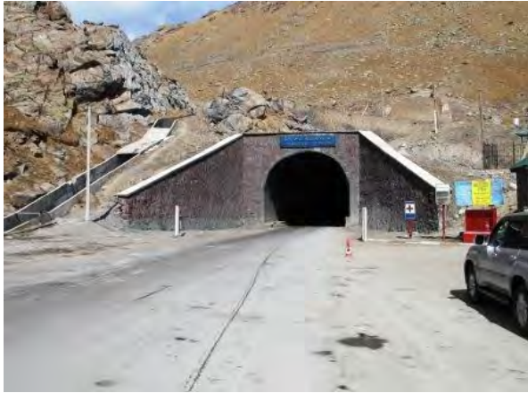
Too-Ashuu 峠に位置する Kolvaev トンネル：幅員が狭く大型車はトンネル内ですれ違うことができないため、坑口付近に大型車用の信号機が設置されている。
