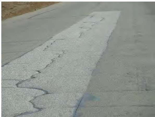
写真 2-5-1 舗装補修状況
