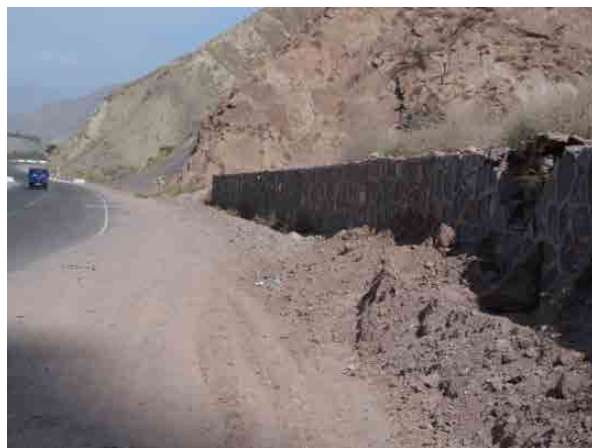
写真 2-5-3 一部の区間でみられる落石防護壁
