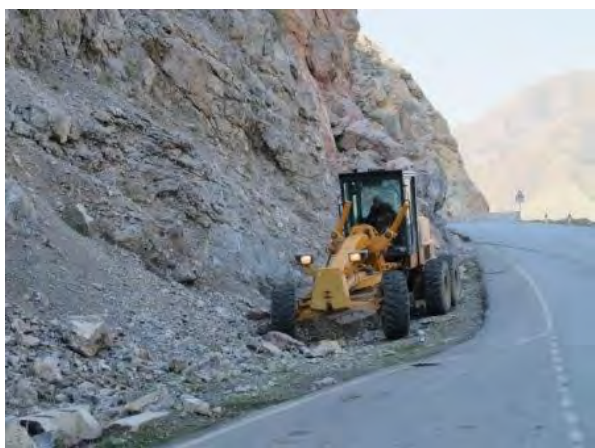
写真 2-5-2 落石除去作業
