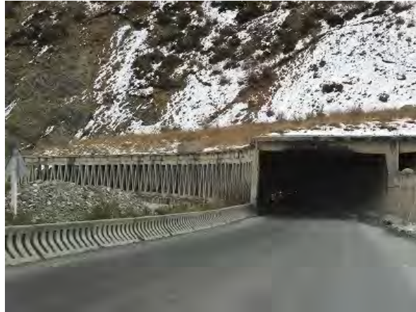
写真 2-5-8 Too-Ashuu 峠付近に存在する洞門
