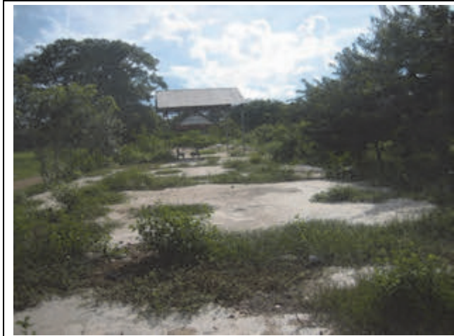
C 校：校舎建設予定地。建物解体後の床スラブ及び基礎が残っている。
