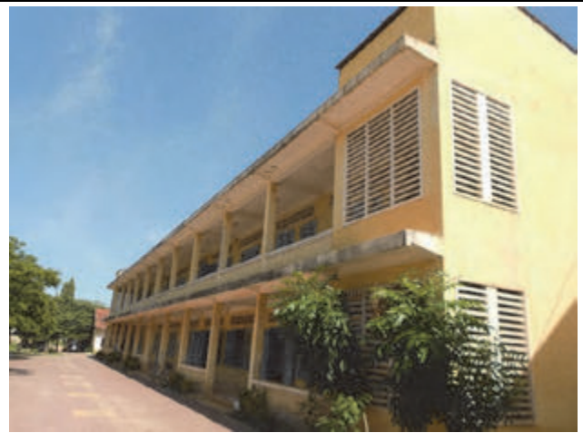
D 校：政府資金により建設された既存 2 階建て校舎。3 階建ての予定が 2 階部分で工事中断。
