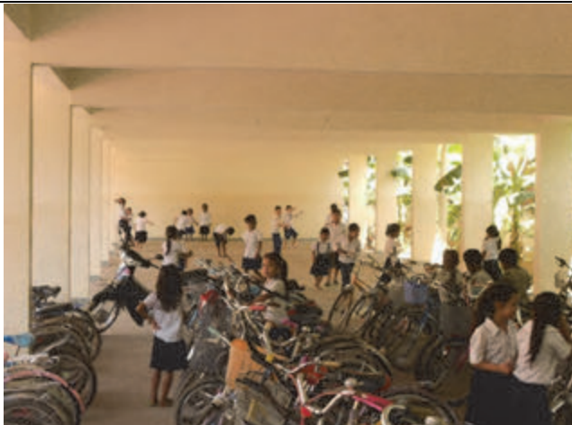
第3次プノンペン小学校建設計画対象校。ピロティが自転車置場兼遊び場として利用されている。
