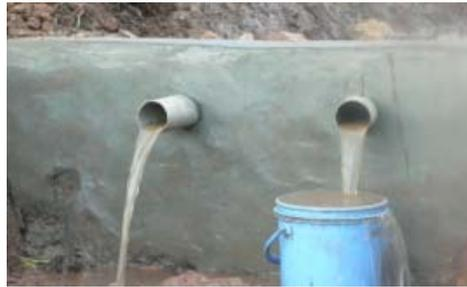
効果の評価：地中壁設置による堰上げ効果は、ほとんど現れなかった。原因として、伏流水の流速が小さいこと、帯水層の規模が小さかったこと、地形及び耕作地に起因する現場条件のため締め切り壁が不完全なものになったこと等が考えられる。ただし、少なくとも 1.3ℓ/sec 程度、より完全に締め切れれば 2.0ℓ/sec 程度の地下水が利用可能であることが確認できた。
