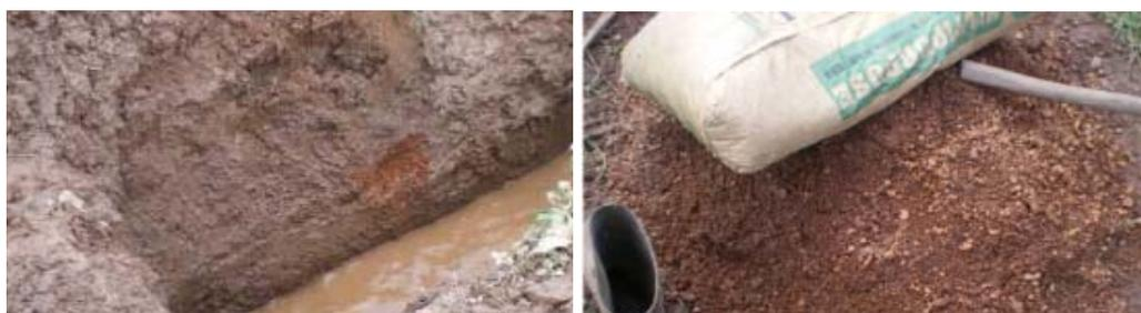
地中締め切り壁をマソンリーにより設置し、締め切り壁に取り付けた流量測定パイプにより伏流水を堰上げた場合の流量を測定。移設後の流量  $Q=1.37\ell/\text{sec}$
