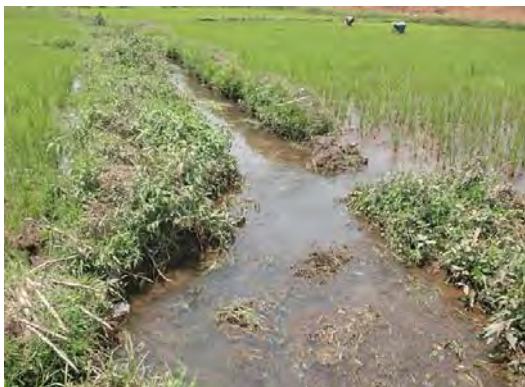
写真-5:水田用排水路 水田の用排水路は整備されておらず、ゲート等の水管理施設も存在しない。
