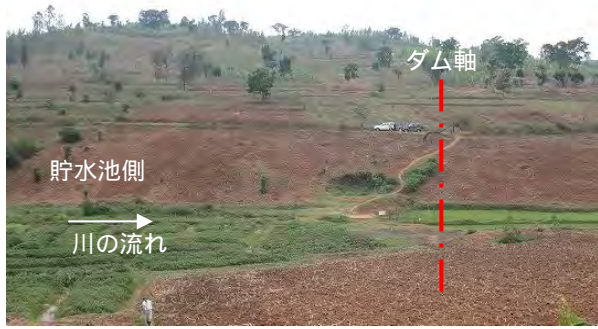
写真-1:ダム軸計画地点付近左岸側 アクセス道路が整備され斜面勾配も緩いため、ポンプ場等の構造物は左岸側に建設予定である。
