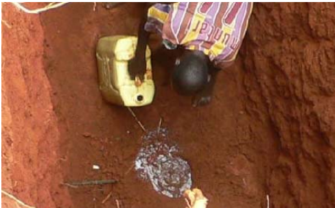
細粒礫注入、スティック建て込み
