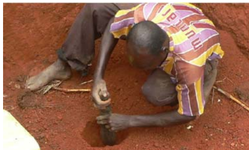
試験孔掘削
