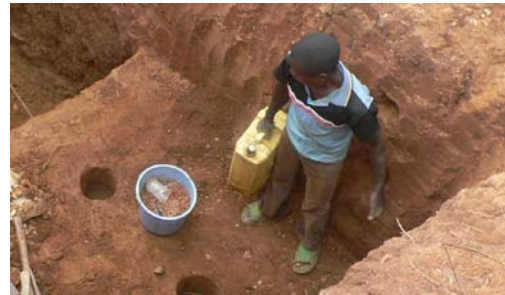
周辺への散水・試験孔注水
