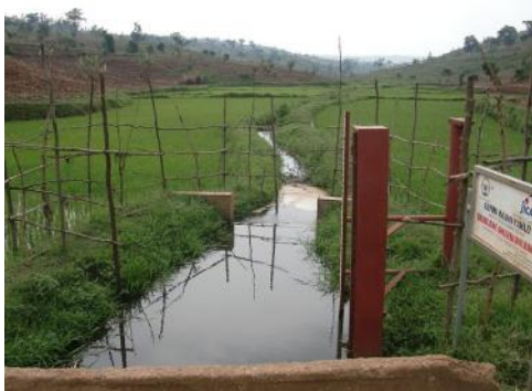
写真 3.2.1.1 流量観測設備
