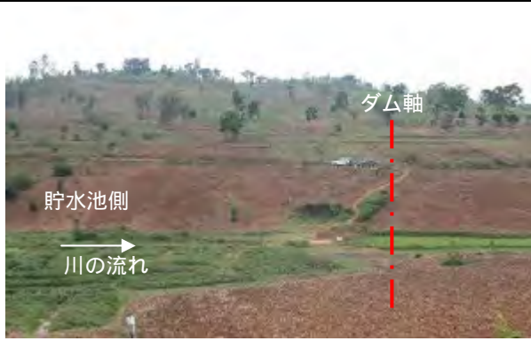
写真-1:ダム軸計画地点付近左岸側 アクセス道路が整備され斜面勾配も緩いため、ポンプ場等の構造物は左岸側に建設予定である。
