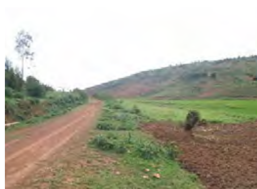
写真-6:幹線水路末端部付近 低位部に道路が整備されており、道路脇にパイプライン形式の幹線を布設する計画である。
