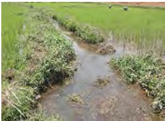
写真-5:水田用排水路 水田の用排水路は整備されておらず、ゲート等の水管理施設も存在しない。
