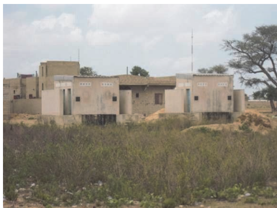
Photo 3 : Blocs de toilettes situés au sud du site du projet
