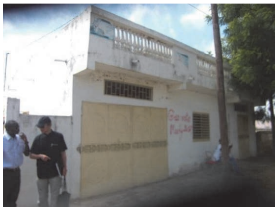
Photo 5 : Bloc d'administration existant (en location) du CREPE de Fatick
