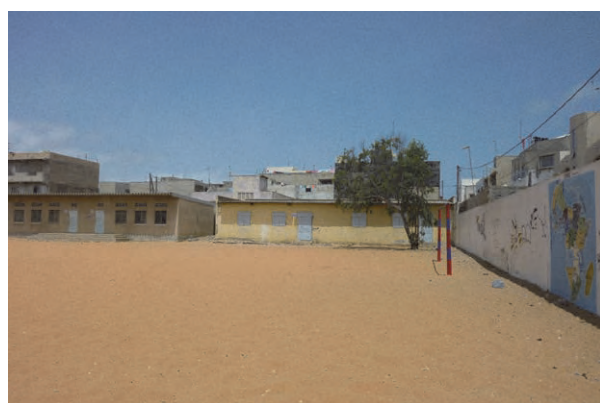
既存中学校の計画サイト 道路境界線（写真右の塀裏）に小規模商店が建ち並び、工事前搬入路が設けられないため、仮設教室（正面）の一部を解体し、搬入路を確保する必要がある。また写真左は一般無償によって建設された校舎（BD-27 ンジアルカ・ジャンヌ中学校）
