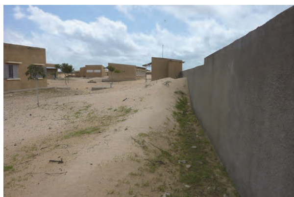
既存中学校の計画サイト 敷地内は、風によって運ばれた砂が堆積し、高低差ができています。工事のため、上記砂の移動（切り土）が必要。 (BD-19 サンガルカム中学校)
