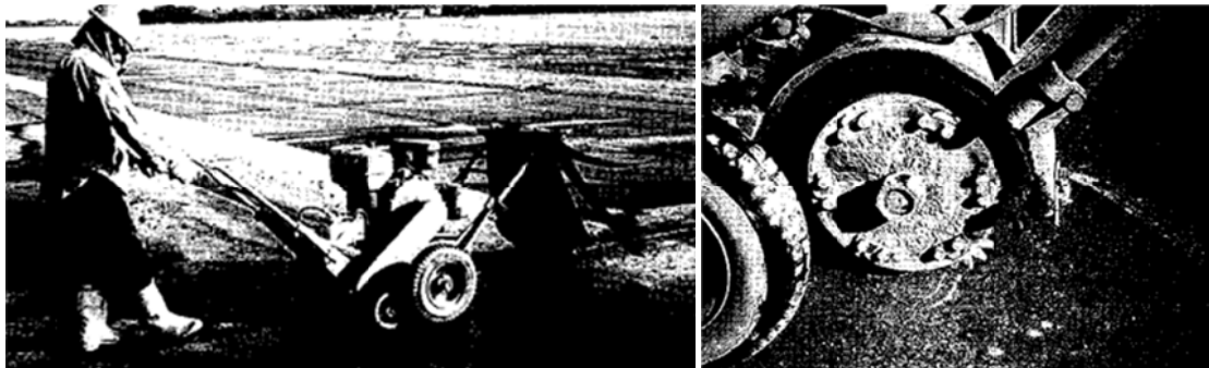
Ảnh 5.6.12 Làm sạch khe nổi (hình trái: toàn cảnh làm sạch khe nổi, hình phải: làm sạch khe)
