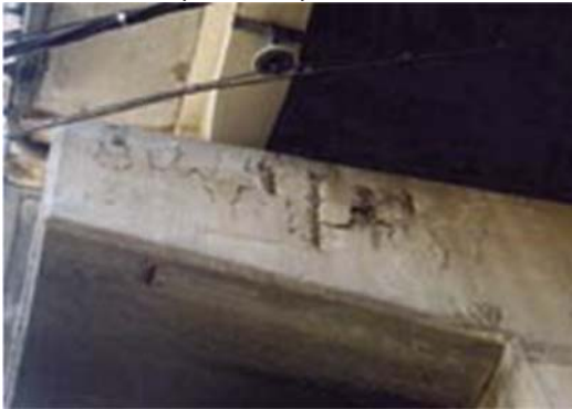
Hình 7: Cầu kiện Dầm trụ
