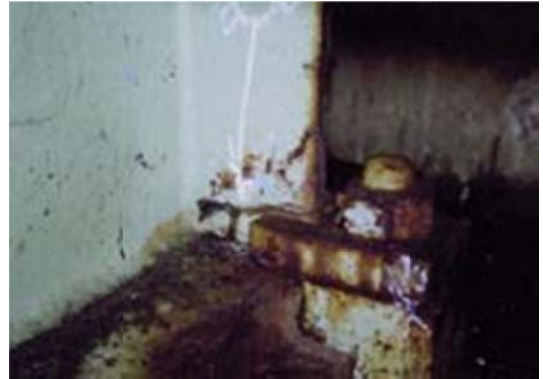
H12. Nứt và ăn mòn với thép mạ kẽm
