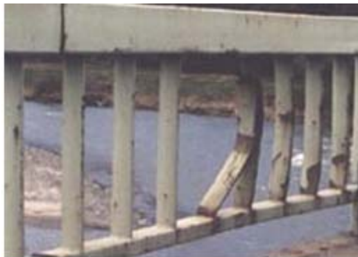
H23.10 Biến dạng và đứt gãy tại lan can
