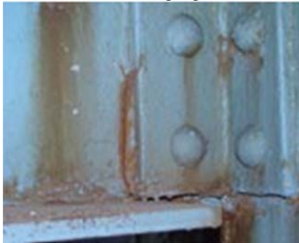
Hình 3: Cấu kiện Dầm ngang
