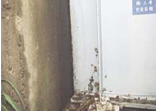
Hình 1 cấu kiện dầm
