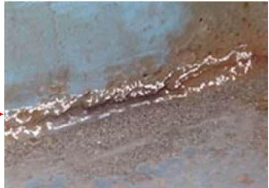
H12. Nứt và ăn mòn với thép mạ kẽm
