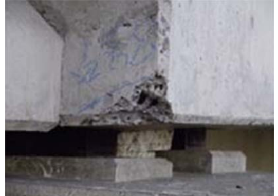
Hình 4: Cầu kiện Dầm
