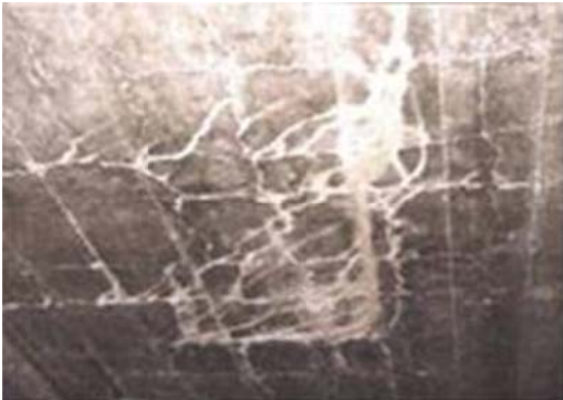
Hình 11: Cấu kiện Bản mặt cầu
