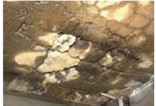
Hình 12: Cấu kiện Bản mặt cầu
