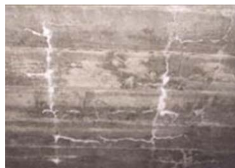
H11.10 Vôi bột từ các vết nứt trên đáy của bản mặt cầu
