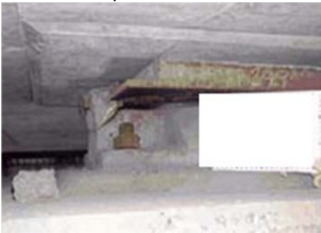
Hình 3: Cầu kiện Gối cầu
