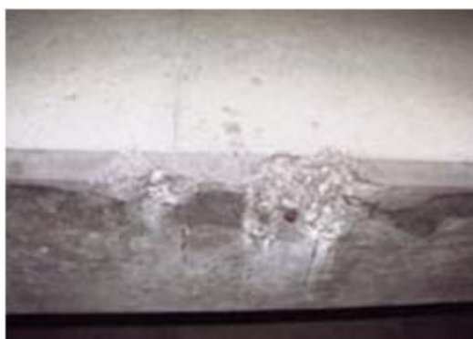
H23.3 Giảm tiết diện ngang với dầm
