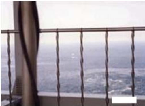
H21.3 Lan can cùng với dây xoắn rung động.
