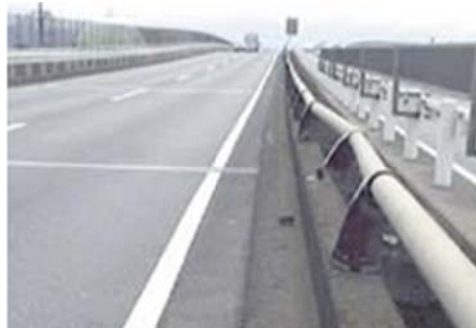
Hình 2: Cấu kiện Lan can
