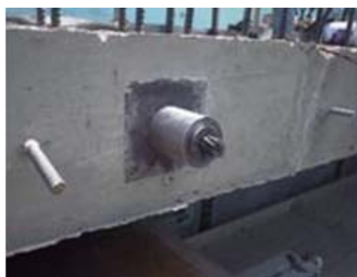
H18.10 Neo dự ứng lực (tốt)
