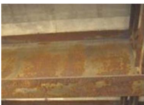
H5.5. Hư rỉ không ổn định trên bề mặt thép chịu thời tiết
