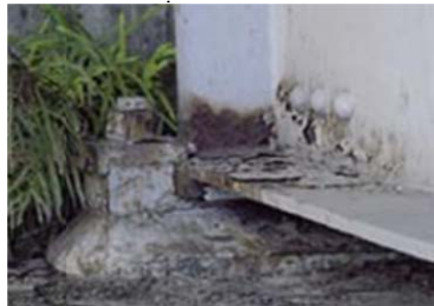
Hình 10: Cầu kiện Gối cầu
