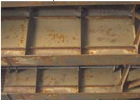
Hình 11: Cấu kiện Dầm
