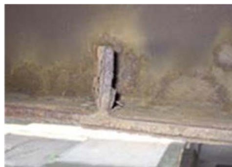
H5.10. Giảm tiết diện ngang với thép chịu thời tiết
