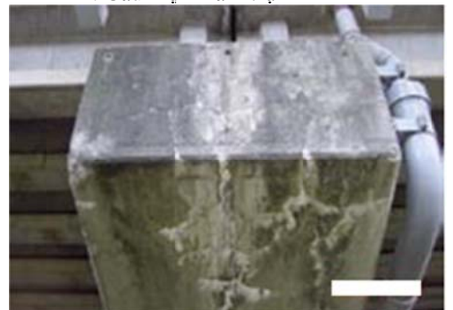
Hình 12: Cầu kiện Dầm trụ
