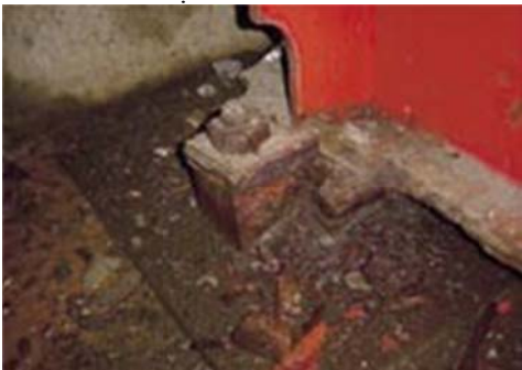
Hình 9: Cầu kiện Gối cầu
