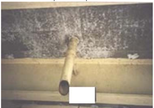
Hình 6: Cầu kiện Bản mặt cầu
