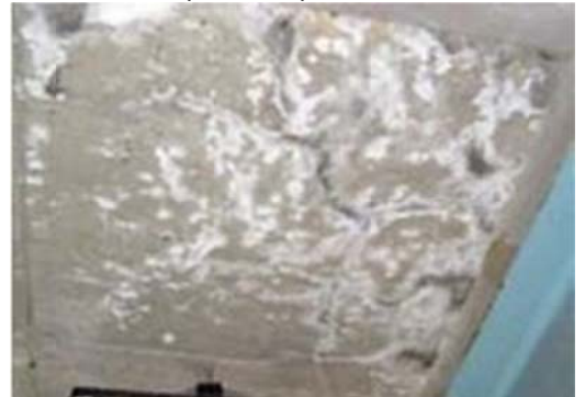
Hình 6: Cấu kiện Bản mặt cầu
