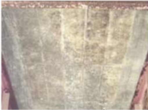
H19.1 Phai màu bản mặt cầu bê tông
