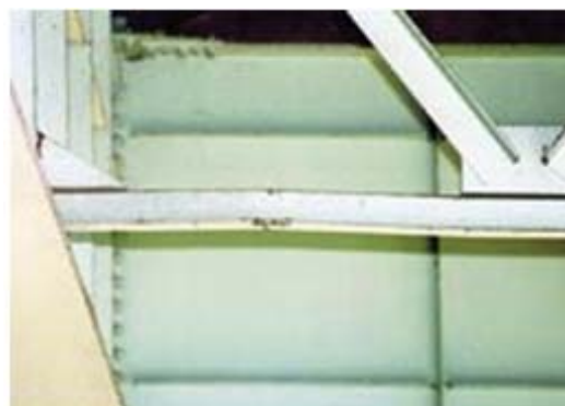
H23.2 Hệ giằng ngang bị biến dạng cục bộ
