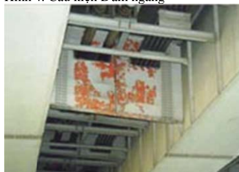
Hình 4: Cấu kiện Dầm ngang
