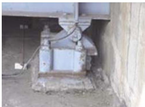
H25.5 Dịch chuyển nghiêm trọng của khe co giãn và gối cầu, sự va chạm giữa dầm và tường chắn do dịch chuyển mố.
