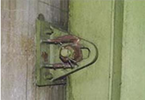
Hình 13: Cấu kiện Hư hỏng cầu
