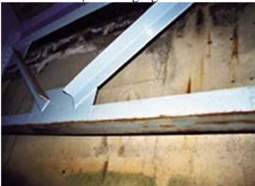
Hình 5: Cấu kiện Dầm ngang
