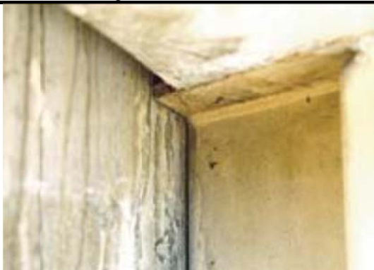
H13.1 Sự va chạm giữa đầu dầm và mố
