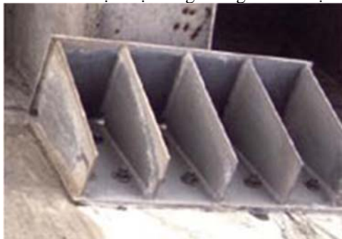
Hình 11: Cấu kiện Hệ thống chống mất ổn định cầu
