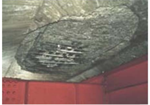
Hình 2: Cấu kiện Bản mặt cầu
