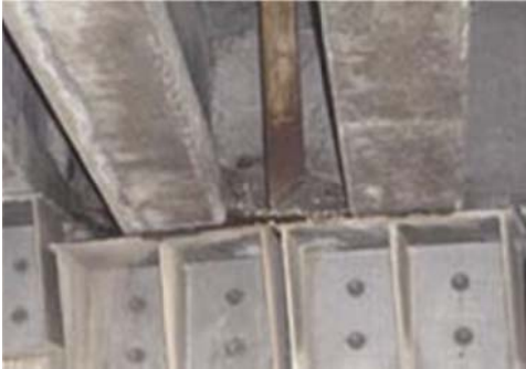
Hình 7: Cấu kiện Hệ thống chống mất ổn định cầu
