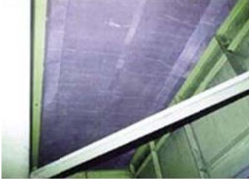
Hình 1: Cấu kiện Bản mặt cầu
