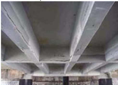
Hình 5: Cấu kiện – Dầm
