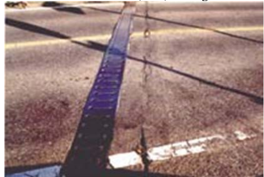
Hình 4: Cấu kiện mặt đường
