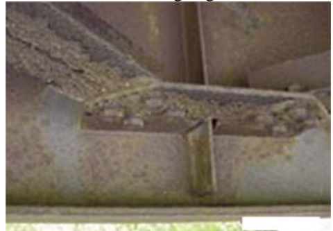
Hình 22: Cấu kiện Hệ giằng lưới
