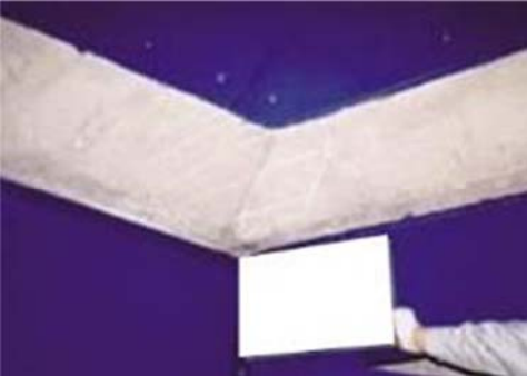
Hình 3: Cầu kiện Bản mặt cầu
