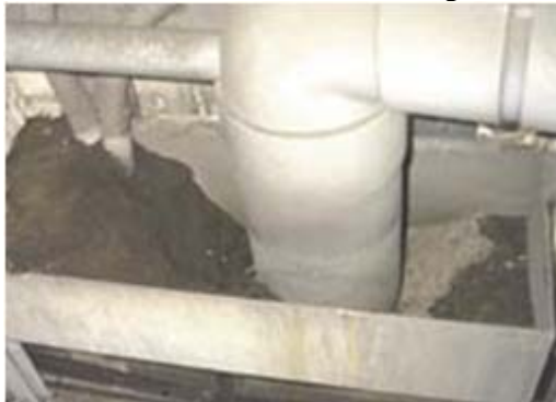
Hình 1: Cấu kiện Bể thu nước của ống thoát nước
