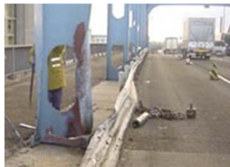
H4.6. Thanh treo bị đứt gãy, vỡ hoặc biến dạng
