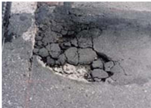
H15.2 Hố đào trên mặt đường
