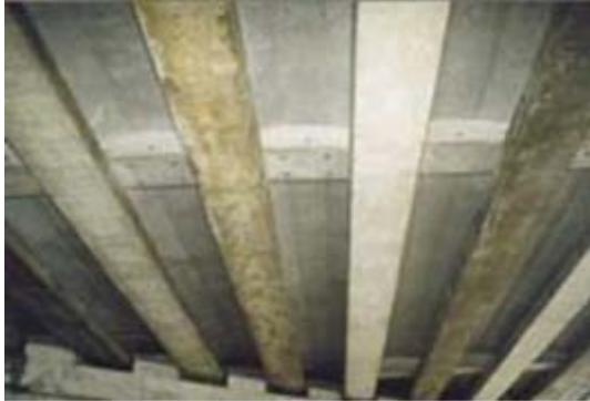
Hình 1: Cấu kiện Dầm
