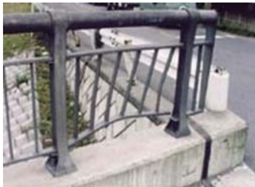
H23.9 Biến dạng và đứt gãy tại lan can của lề người đi bộ
