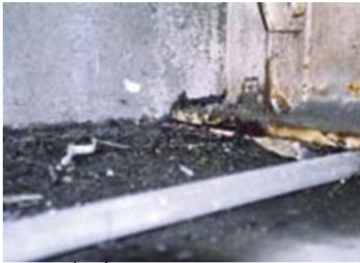
H24.3 Chất đông mảnh vụn và rác xung quanh chân gói cầu.
