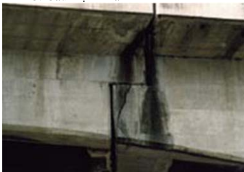
Hình 3: Cấu kiện - Dầm
