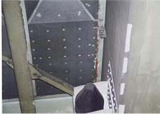
Hình 1: Cấu kiện Bản mặt cầu
