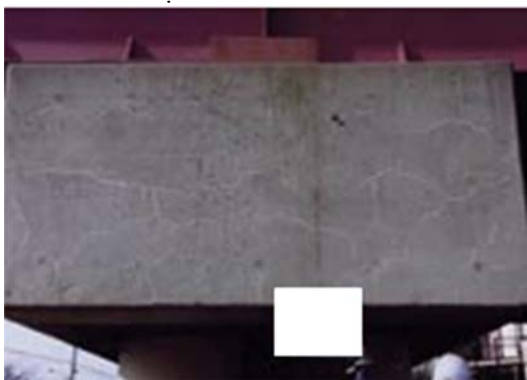
Hình 3: Cầu kiện Dầm
