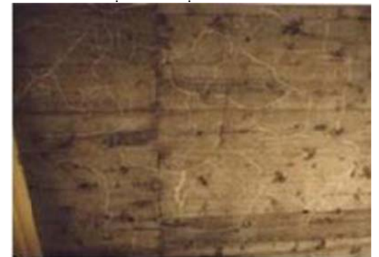
Hình 6: Cấu kiện Bản mặt cầu
