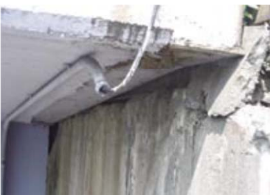
H13.5 Tường chắn hư hỏng do sự va chạm giữa bản mặt cầu và tường chắn
