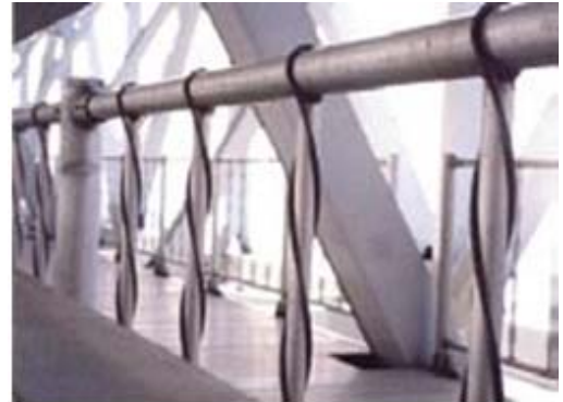
H21.4 Lan can cùng với dây xoắn rung động.
