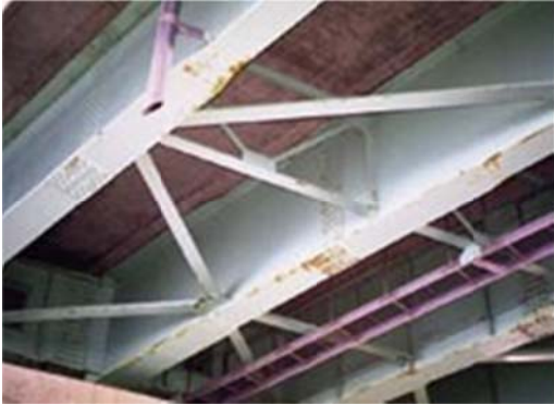
Hình 1: Cấu kiện Dầm chủ
