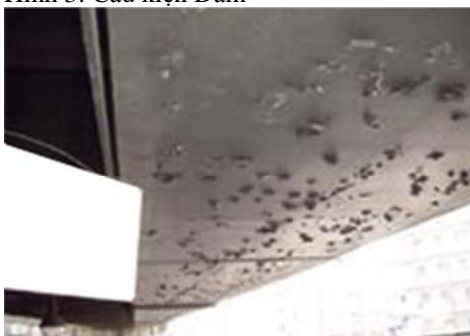
Hình 3: Cấu kiện Dầm
