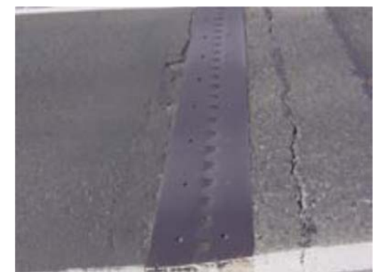
H13.6 Vết nứt trên mặt đường do khe co giãn khép kín chặt vào nhau
