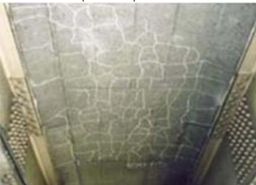
Hình 5: Cấu kiện Bản mặt cầu
