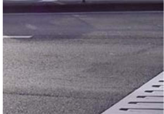
Hình 2: Cấu kiện mặt đường
