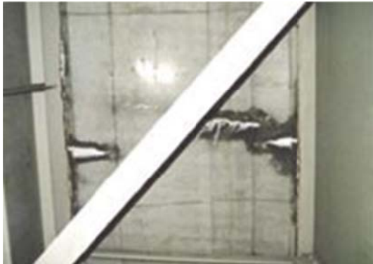
Hình 3: Cầu kiện Bàn mặt cầu
