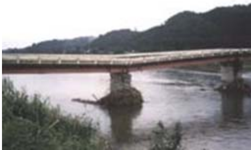
H22.1 Lún kết cấu phần dưới dẫn đến võng kết cấu phần trên
