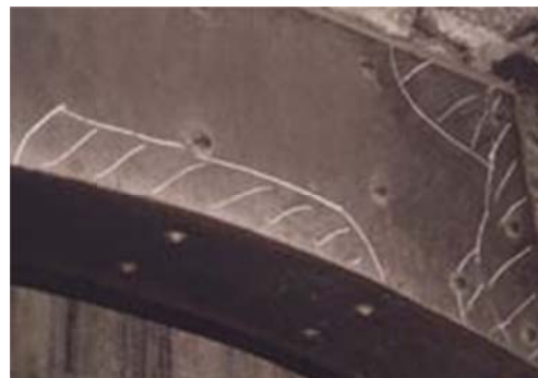
H10.2 Phồng bản thép tăng cường với dầm
