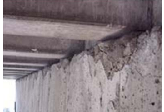
Hình 2: Cầu kiện Dầm tại trụ
