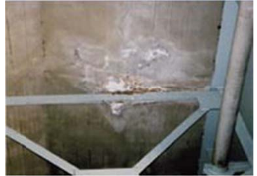
Hình 8: Cầu kiện Bản mặt cầu
