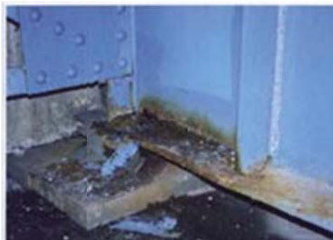
H4. Ăn mòn tại đầu dầm hoặc gối cầu do nước và vụn rác
