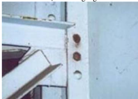
Hình 4: Cấu kiện Dầm ngang
