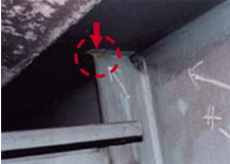
Hình 1: Cấu kiện Dầm
