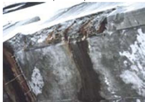
Hình 6: Cầu kiện Bản mặt cầu
