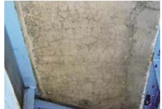
Hình 10: Cấu kiện Bản mặt cầu
