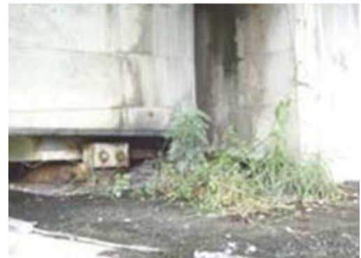
H24.4 Chất đông mảnh vụn và rác xung quanh chân gói cầu.
