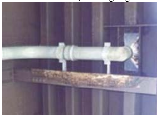
Hình 5: Cấu kiện Đường ống thoát nước
