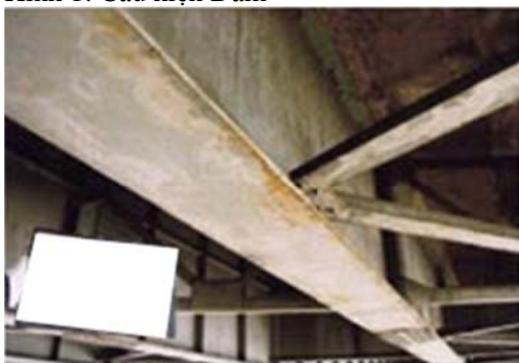
Hình 1: Cấu kiện Dầm
