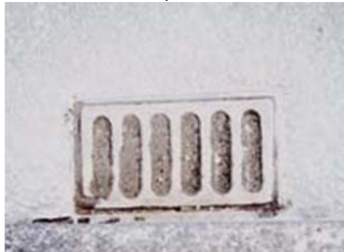
Hình 6: Cấu kiện Hồ thu nước
