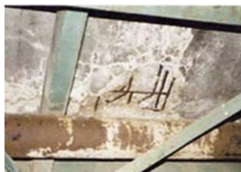
H11.8 Nứt, bong tróc bê tông, cốt thép lộ ra tại đáy của bản mặt cầu
