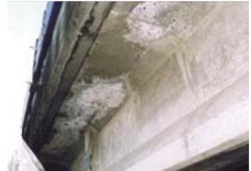
Hình 2: Cầu kiện Bản mặt cầu
