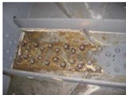
H20.3 Nước đọng và ăn mòn trong dầm hộp do rò rỉ nước từ bể thu nước
