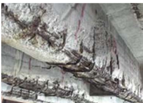
H7.9. Thép lộ ra bị ăn mòn và đứt gãy
