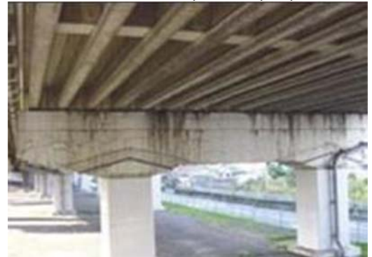
Hình 4: Cấu kiện Dầm tại trụ
