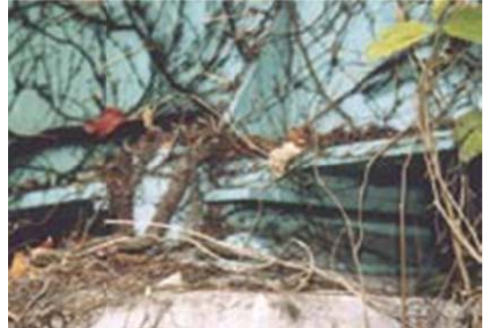
Hình10: Cầu kiện Gối cầu
