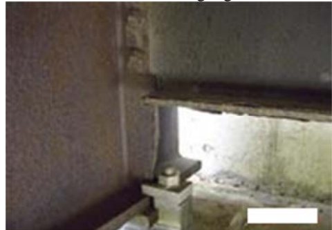
Hình 24: Cấu kiện Dầm ngang
