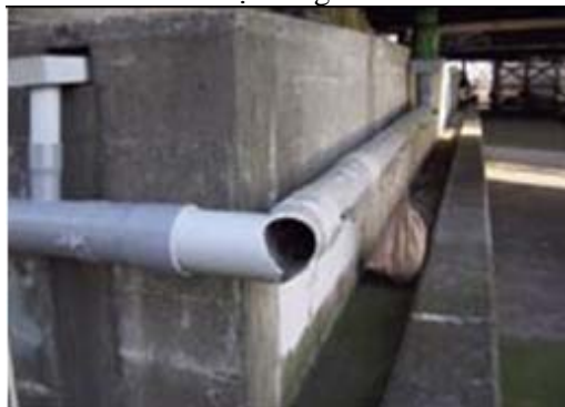
Hình 5: Cầu kiện Ống thoát nước
