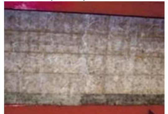
Hình 4: Cấu kiện Bản mặt cầu
