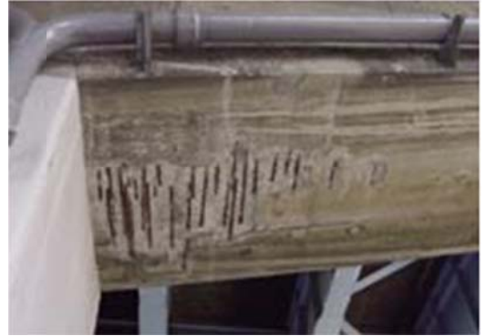
Hình 8: Cầu kiện Dầm trụ
