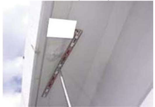
Hình 2: Cấu kiện Bản mặt cầu
