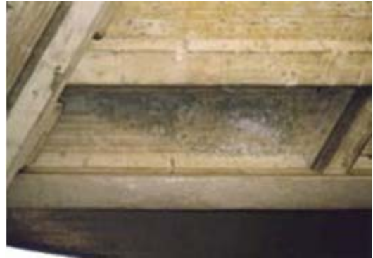
H19.2 Phai màu bản mặt cầu bê tông
