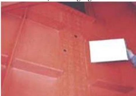
Hình 1: Cấu kiện Dầm ngang
