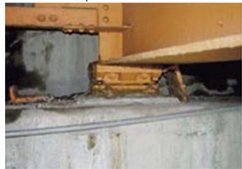
Hình 6: Cầu kiện Gối cầu
