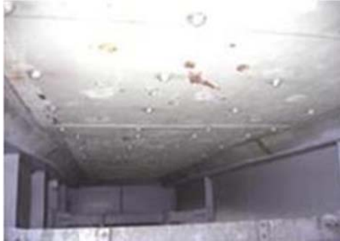
Hình 1: Cấu kiện Bản mặt cầu
