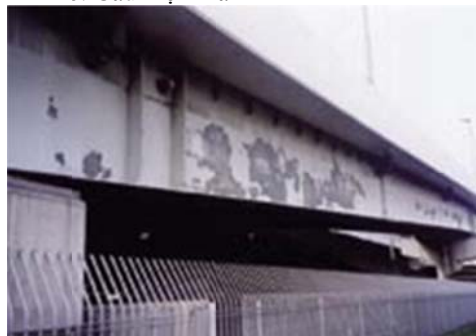
Hình 6: Cấu kiện Dầm
