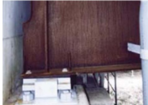
Hình 10: Cấu kiện Dầm
