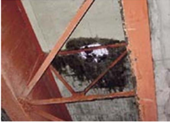
Hình 1: Cấu kiện Bản mặt cầu
