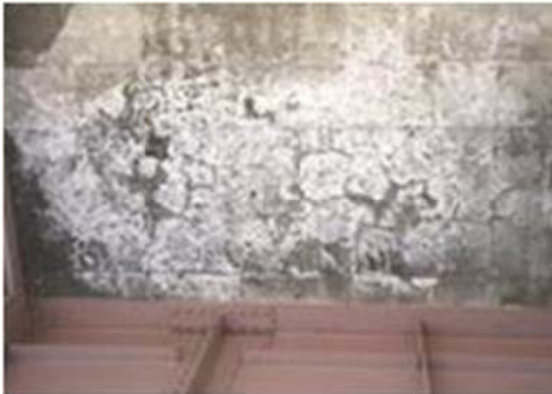
Hình 9: Cấu kiện Bản mặt cầu
