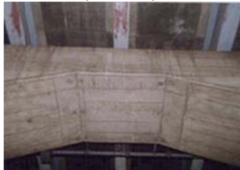
Hình 2: Cấu kiện – Dầm trụ
