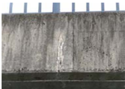
H8.1 Các vết nứt trên tường lan can và vôi bột xuất hiện giữa các mối nối
