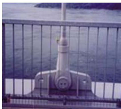
H18.6 Phần neo giữ cáp của cầu treodây võng (tốt)
