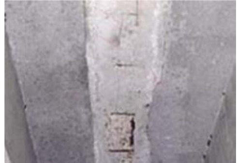
Hình 4: Cầu kiện Bản mặt cầu
