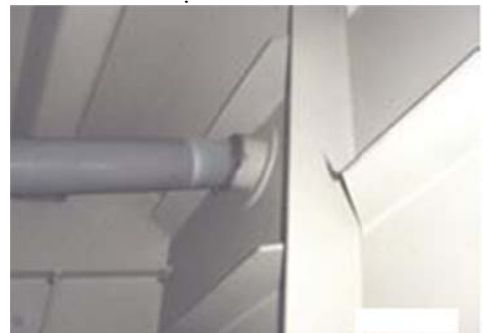
Hình 18: Cấu kiện Dầm
