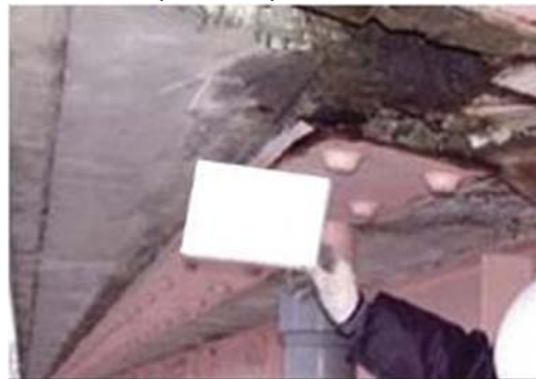
Hình 3: Cấu kiện Bản mặt cầu
