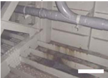
Hình 17: Cấu kiện Dầm
