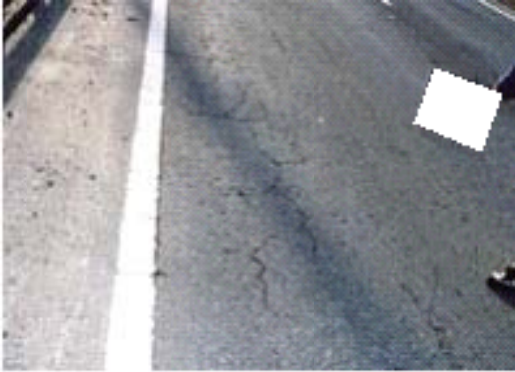
Hình 1: Cấu kiện mặt đường
