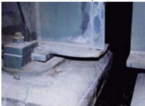
Hình 5: Cấu kiện Dầm
