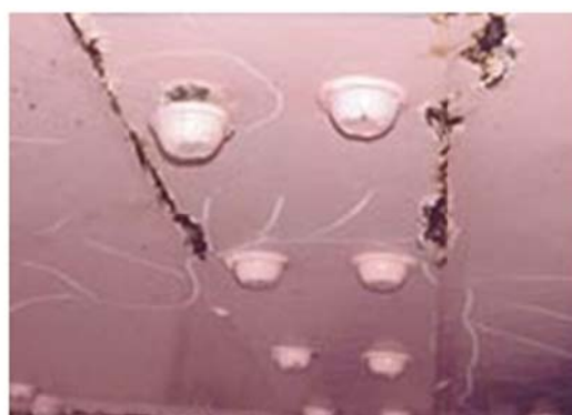
H10.3 Ăn mòn do phồng xảy ra tại bản thép tăng cường, sau đó bu lông neo bị lỏng ra.
