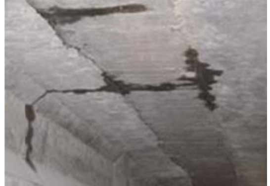
Hình 2: Cầu kiện Bàn mặt cầu
