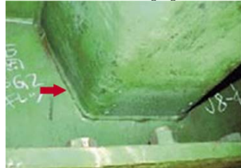
Hình 8: Cấu kiện Dầm ngang
