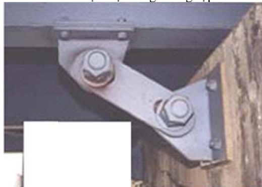
Hình 6 cấu kiện Hệ thống chống sụp đổ cầu
