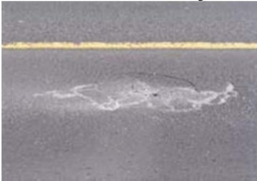
Hình 3: Cấu kiện mặt đường
