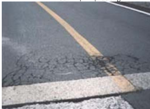
Hình 2: Cấu kiện mặt đường
