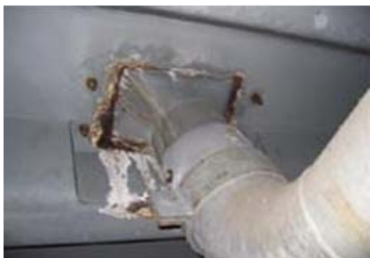
H20.3 Nước đọng và ăn mòn trong dầm hộp do rò rỉ nước từ bể thu nước
