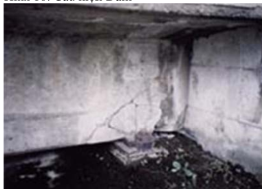
Hình 10: Cầu kiện Dầm
