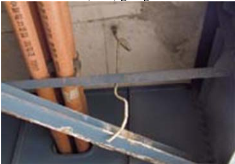
Hình 15: Cấu kiện Hệ giăng lưới
