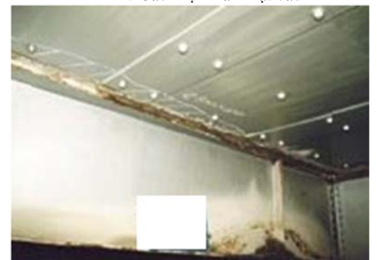
Hình 4: Cấu kiện Bản mặt cầu
