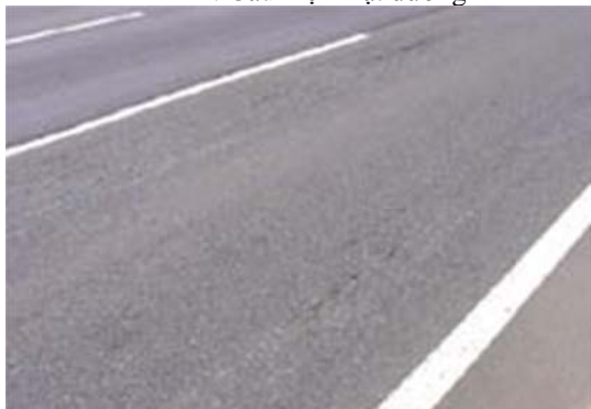
Hình 1: Cấu kiện mặt đường
