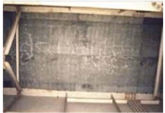
Hình 2: Cấu kiện Bản mặt cầu
