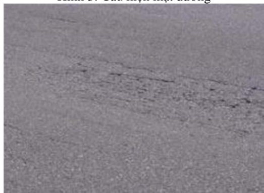
Hình 3: Cấu kiện mặt đường
