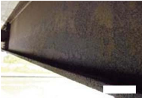
Hình 21: Cấu kiện Dầm
