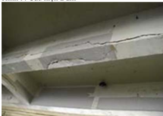
Hình 9: Cầu kiện Dầm
