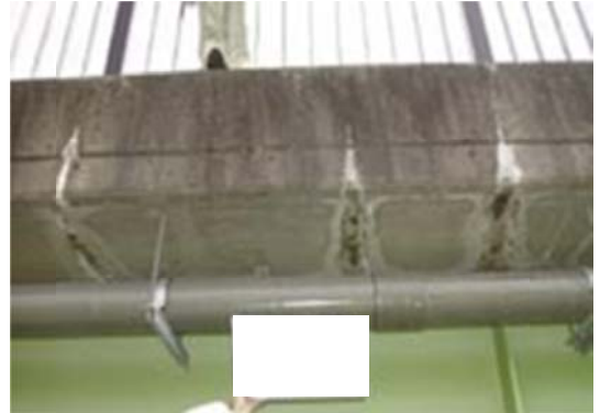
Hình 6: Cầu kiện Bàn mặt cầu
