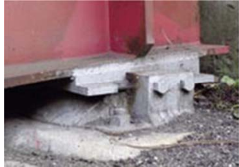
Hình 8: Cấu kiện Dầm
