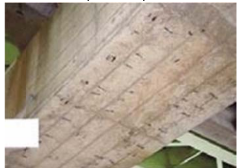
Hình 4: Cầu kiện Dầm trụ
