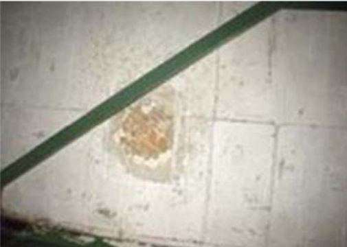
Hình 5: Cầu kiện Bản mặt cầu
