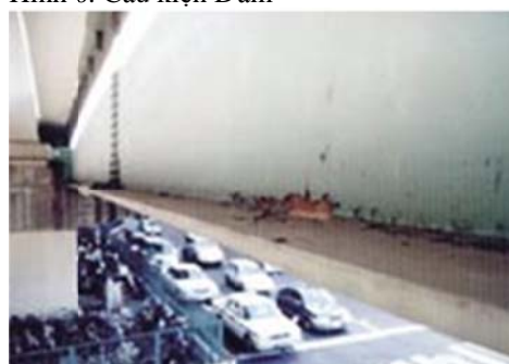
Hình 6: Cấu kiện Dầm
