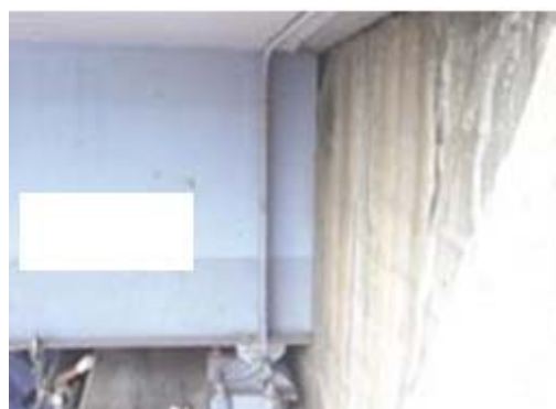
H25.5 Dịch chuyển nghiêm trọng của khe co giãn và gối cầu, sự va chạm giữa dầm và tường chắn do dịch chuyển mố.
