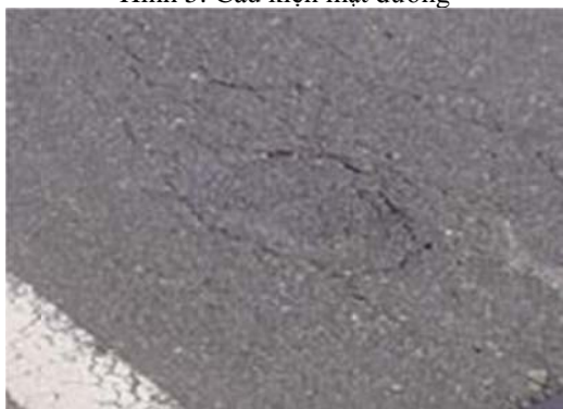
Hình 5: Cấu kiện mặt đường
