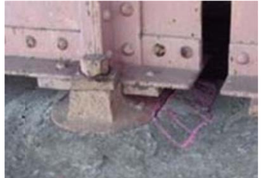
Hình 6: Cầu kiện Gối cầu
