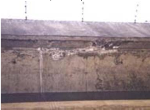
Hình 3: Cầu kiện Bản mặt cầu
