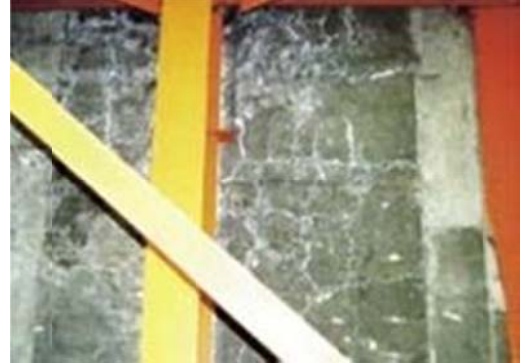
Hình 8: Cấu kiện Bản mặt cầu
