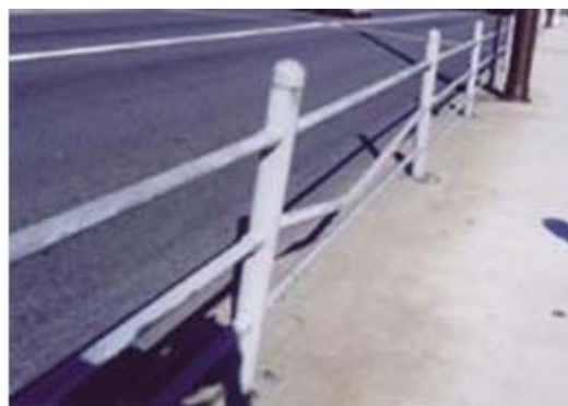
H23.4 Biến dạng xảy ra tại lan can
