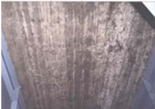
Hình 5: Cấu kiện Bản mặt cầu
