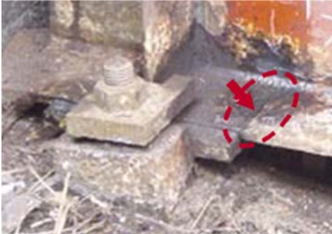
Hình 3: Cấu kiện Dầm
