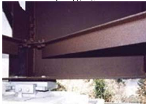
Hình 14: Cấu kiện Hệ giằng dưới
