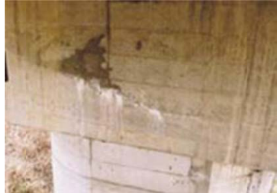
Hình 4: Cầu kiện Dầm
