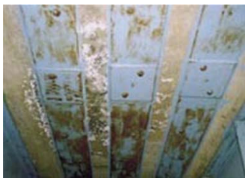
H10.5 Vôi bột xuất hiện tại bản thép tăng cường ở đáy của bản mặt cầu
