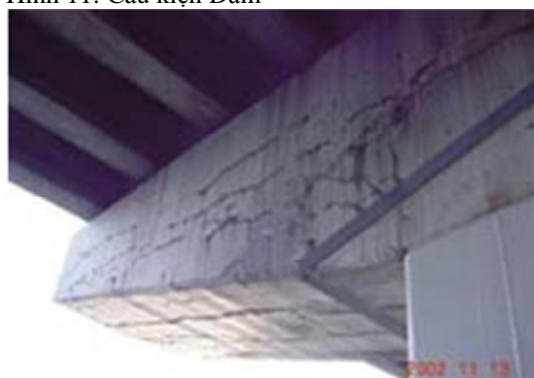
Hình 11: Cầu kiện Dầm
