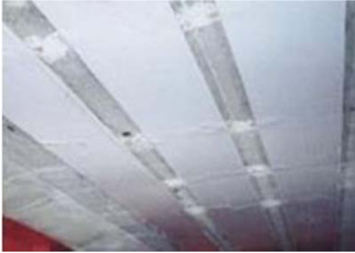
Hình 1: Cấu kiện Bản mặt cầu
