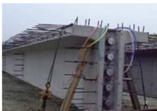
H18.9 Neo dự ứng lực (tốt)
