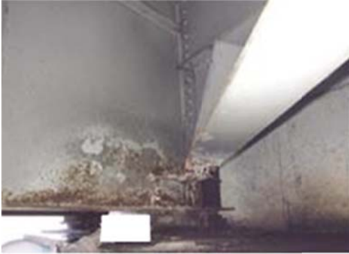
Hình 7: Cấu kiện Dầm
