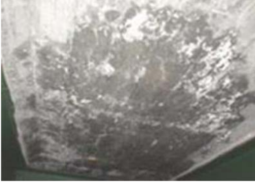
Hình 7: Cấu kiện Bản mặt cầu
