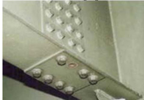
Hình 4: Cấu kiện Dầm ngang
