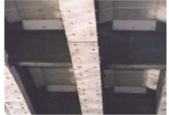
Hình 2: Cấu kiện Dầm
