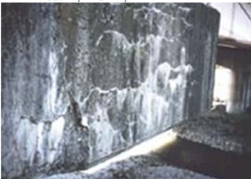
Hình 11: Cầu kiện Dầm trụ
