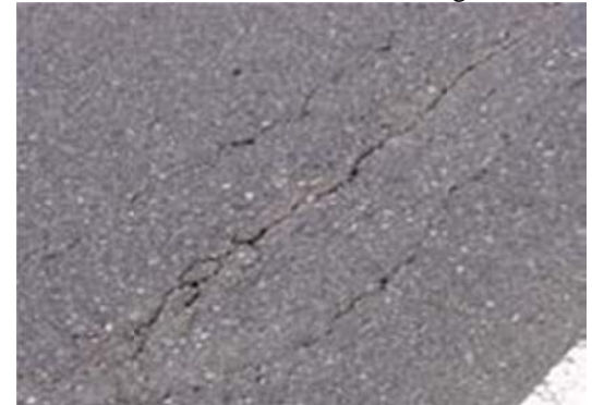
Hình 4: Cấu kiện mặt đường
