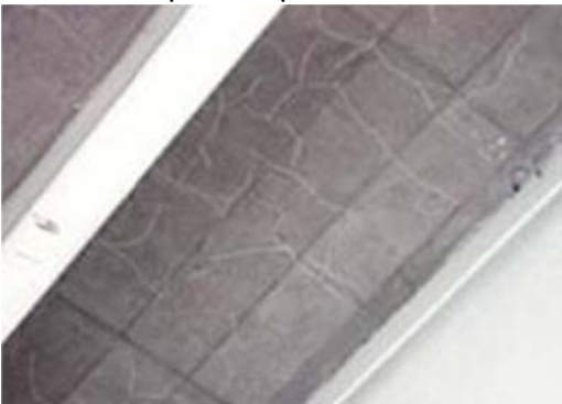
Hình 3: Cấu kiện Bản mặt cầu
