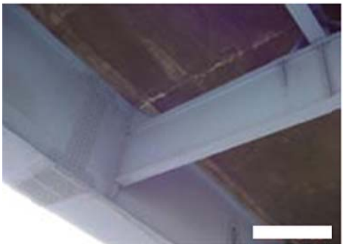
Hình 4: Cầu kiện Bản mặt cầu
