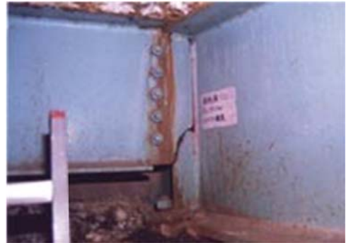
H4.2. Đầu giằng (dầm ngang) đã bị đứt gãy
