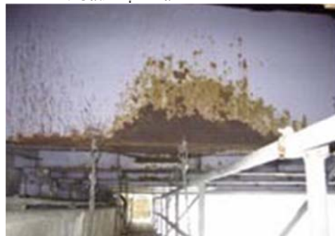
Hình 12: Cầu kiện Dầm
