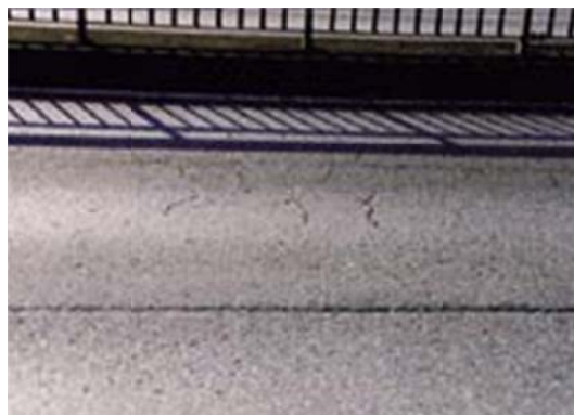
Hình 4: Cấu kiện mặt đường
