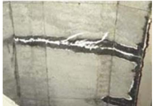
Hình 4: Cấu kiện Bản mặt cầu
