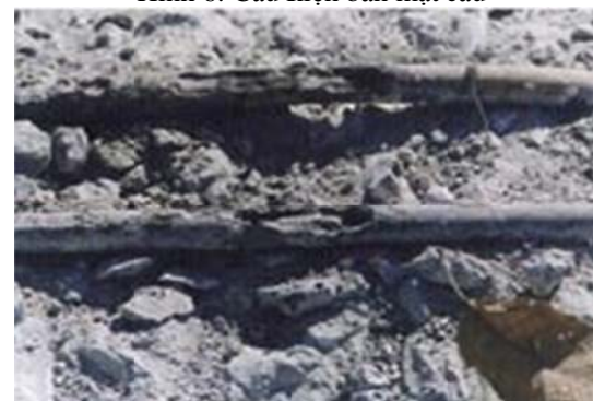
Hình 6: Cấu kiện bản mặt cầu
