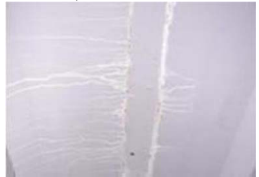
Hình 4: Cấu kiện Dầm
