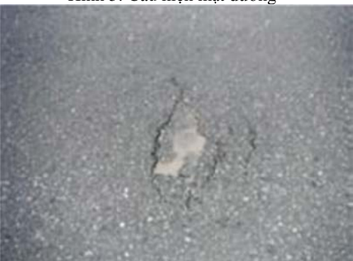
Hình 5: Cấu kiện mặt đường
