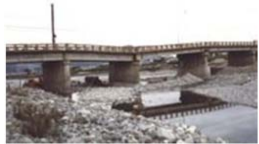
H22.2 Lún kết cấu phần dưới dẫn đến võng kết cấu phần trên
