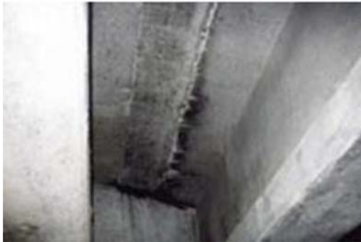
Hình 3: Cấu kiện Bản mặt cầu
