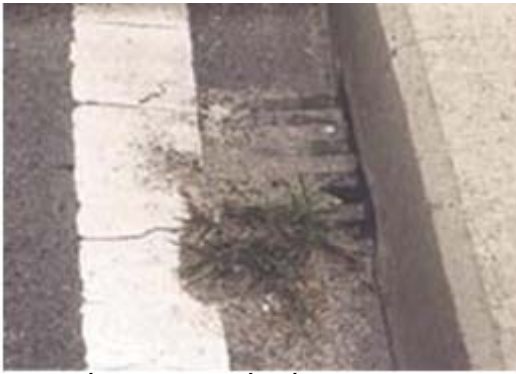
H24.1 Hồ thu nước chất đông mảnh vụn và rác.
