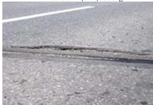
Hình 6: Cấu kiện mặt đường
