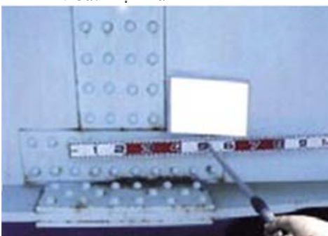
Hình 11: Cầu kiện Dầm
