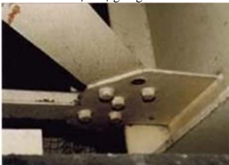
Hình 3: Cấu kiện Hệ giằng dưới
