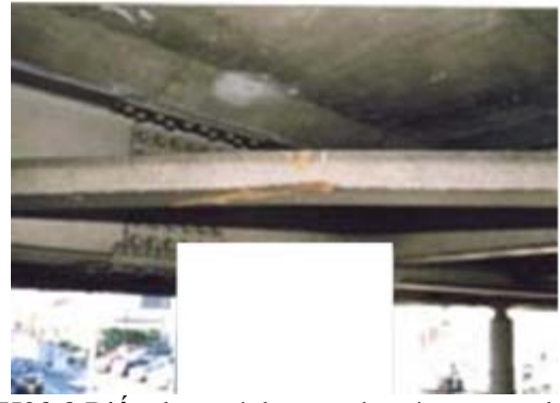
H23.8 Biến dạng và bong tróc màng sơn trên hệ giằng ngang phía dưới
