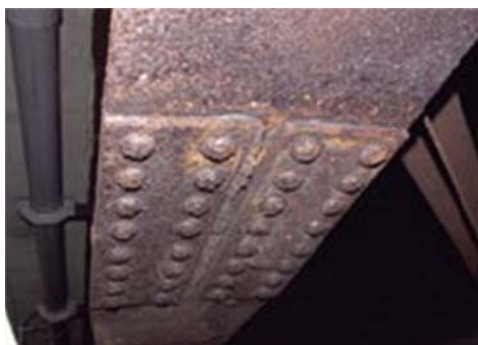
H7. Ăn mòn không đồng đều và không giảm tiết diện ngang với thép chịu thời tiết
