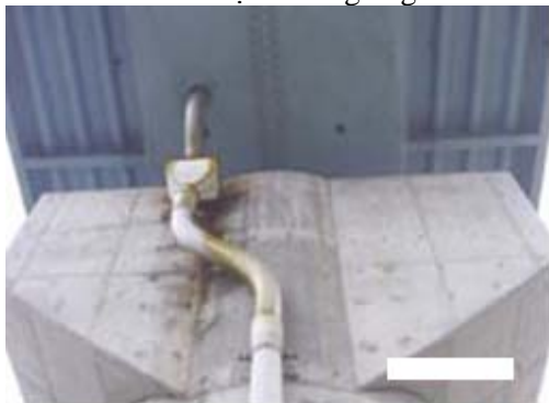
Hình 4: Cấu kiện Đường ống thoát nước
