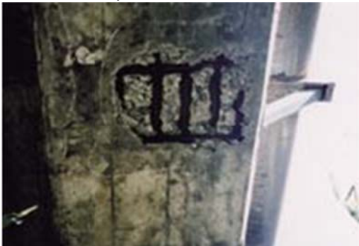
Hình 5: Cầu kiện Dầm
