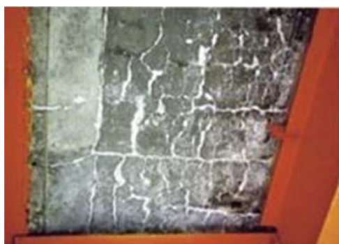
H11.11 Nước rò rỉ và vôi bột từ các vết nứt tại đáy của bản mặt cầu
