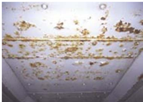
H10.1 Ăn mòn tại bản thép tăng cường ở phần đáy của bản mặt cầu
