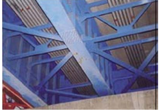
Hình 2: Cấu kiện Dầm
