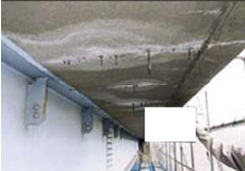
Hình 1: Cầu kiện Bản mặt cầu
