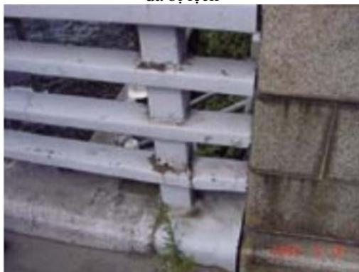
H13.11 Lan can hư hỏng do khe hở bất thường
