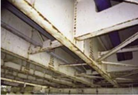
Hình 1: Cấu kiện Dầm
