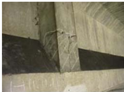
H18.8 Nứt trên phần neo cốt thép dự ứng lực ngang của bê tông
