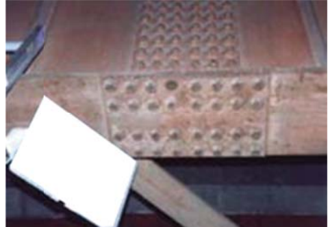
Hình 2: Cấu kiện Dầm
