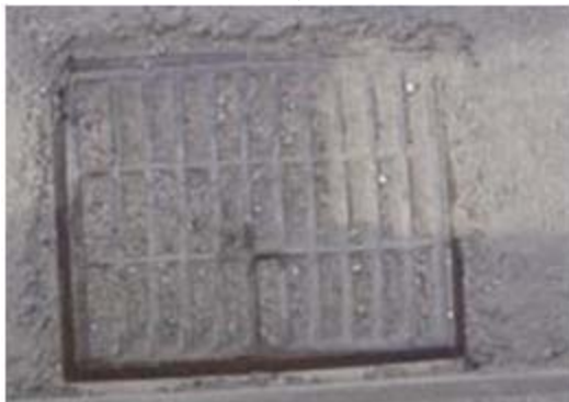
Hình 1: Cấu kiện Hồ thu nước
