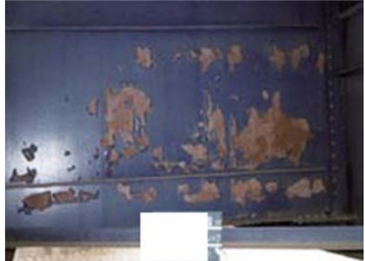
Hình 4: Cấu kiện Dầm
