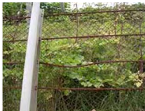
Ảnh 5.8 Ăn mòn và đứt gãy cấu kiện thép (lưới phòng chống đá rơi)
