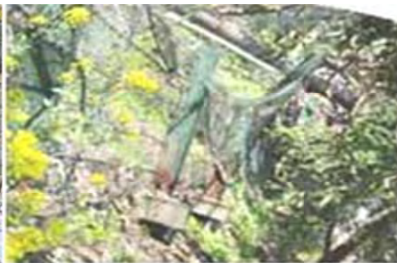
Ảnh 5.2: Biến dạng và nghiêng cấu kiện (Phòng chống đá rơi)
