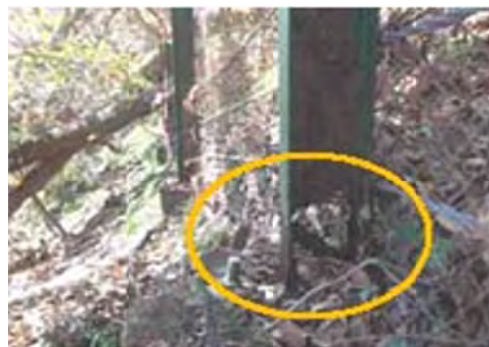
Ảnh 5.6 Ăn mòn cấu kiện thép (chân dầm chữ H phòng chống đá rơi)
