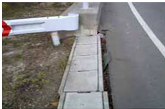
Ảnh 7.8 Trục trặc chức năng của hệ thống thoát nước
