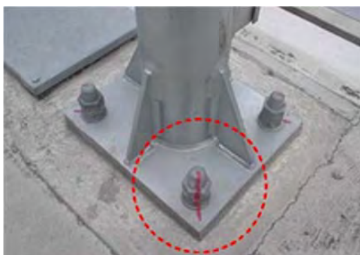
(a) Tốt Quan sát dễ dàng và đánh dấu đủ đảm bảo chiều dài từ bu lông tới bản
