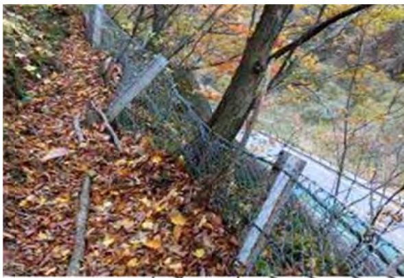
Ảnh 5.1 Biến dạng và nghiêng cấu kiện (Phòng chống đá rơi)
