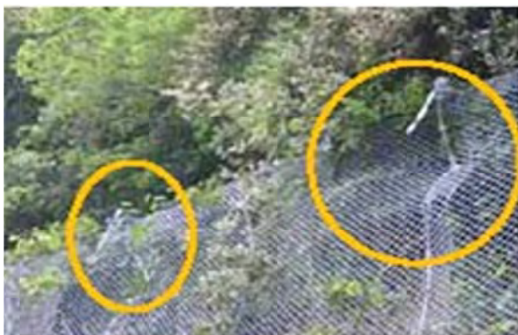
Ảnh 5.3 Lưới phòng chống đá rơi, (nghiêng trụ, đứt gãy lưới, đứt vỡ sợi thép)
