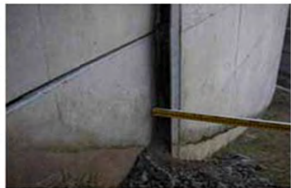
Ảnh 7.7 : Khe hở mở rộng và dòng cặn lắng
