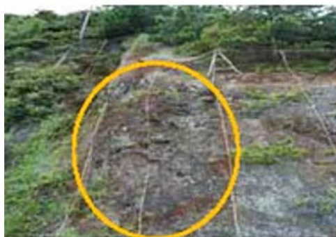
Ảnh 5.7 Ăn mòn và đứt gãy của cấu kiện thép (lưới phòng chống đá rơi)
