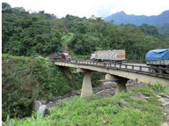
橋梁パイロット工事予定地視察 (7号線コチャバンバ県)
