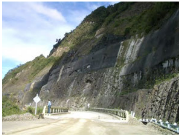
斜面防災工事施工箇所 (ロックアンカー)
