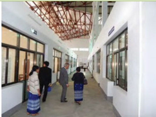
写真-9：マンダレー工科大学既存施設（土木学科の研究棟）。比較的新しく、構造的には問題がない。
