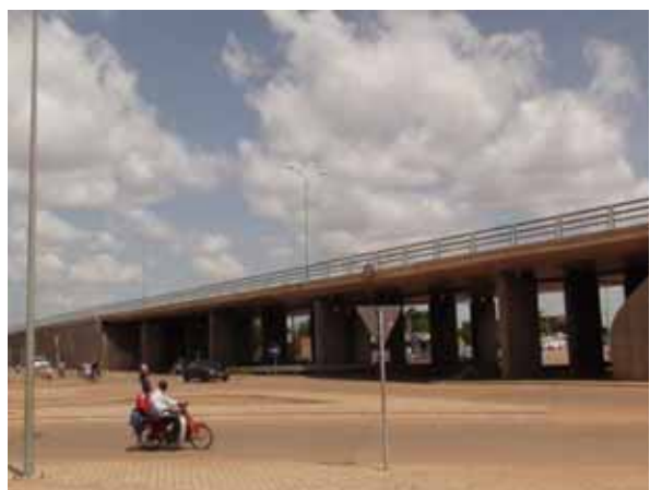
写真12 2KRの見返り資金を使って建設された立体交差（ワガドゥグ市内）：2006年に日本側との協議承認を得て建設が進められた。総額は27億FCFA。
