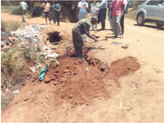
配管修理 (エンブ)
