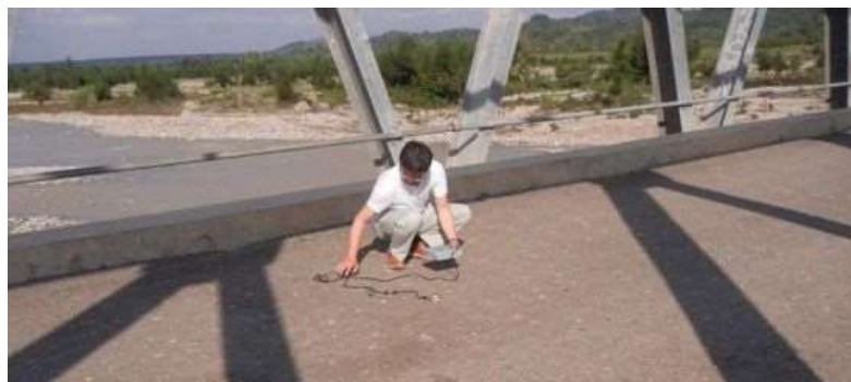
図 2-1-9 簡易振動計による振動計測
