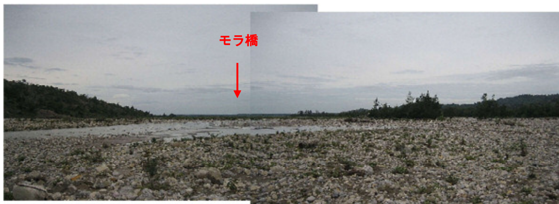
図 2-1-15 モラ橋より上流 1.5km 上流地点より下流を望む
