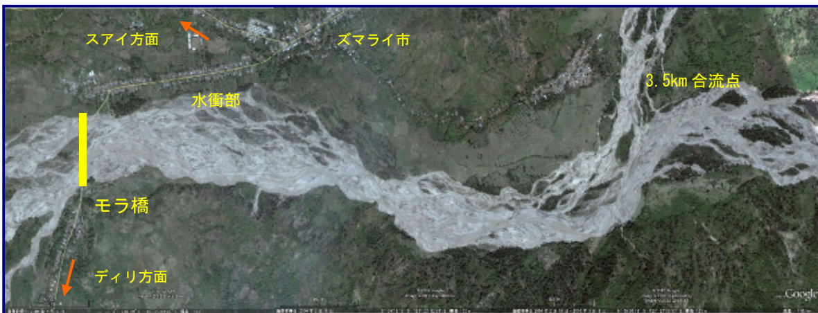
図 2-1-13 モラ橋付近の状況
