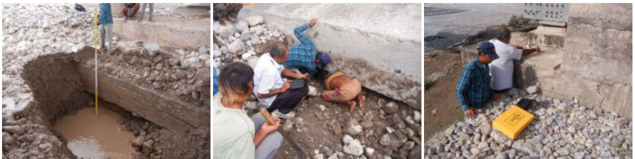
a. P1 橋脚 (試掘調査による形状調査)
