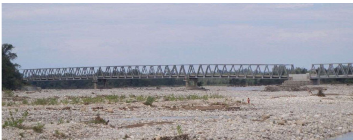
図 2-1-3 既設モラ橋の全景 （上流から見たところであり、左がディリ方面、右がスアイ方面になる。）
