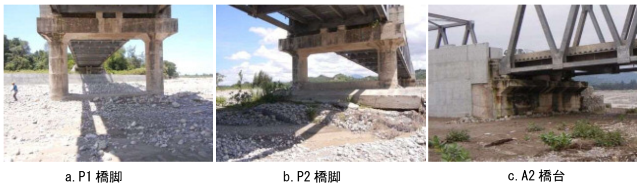
図 2-1-10 下部工の現況写真
