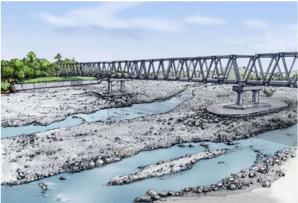
左岸側護岸工・橋脚基礎防護工付近
