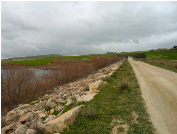
堤体天端道路
