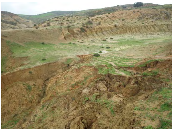
洪水吐急流部始点 激しく侵食されている。
