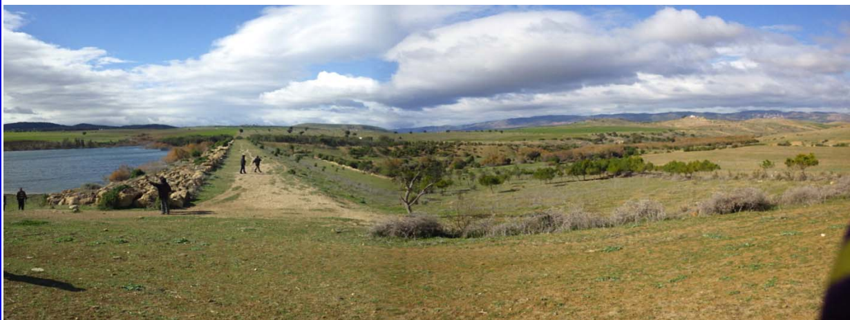
ダム右岸側から堤体天端及びダム下流部
