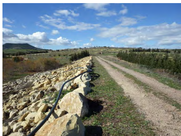
ダム上流面、パイプライン、左岸側
