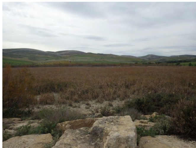
図 3.10 完全に堆砂で埋まった SI-6 Zaaroura Dam 貯水池 (Jan. 23, 2014)
