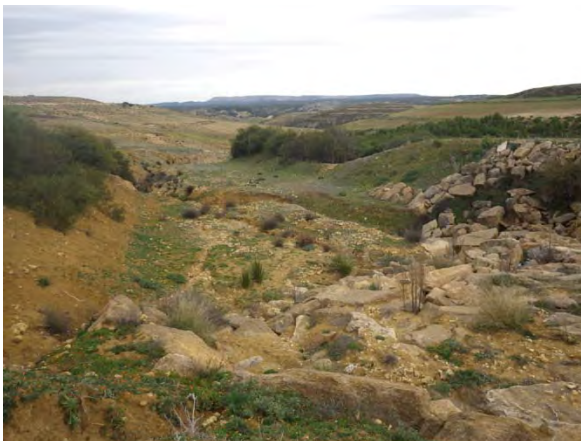
洪水吐急流部
