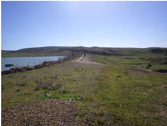
堤体天端。正面奥岡上に調整水槽
