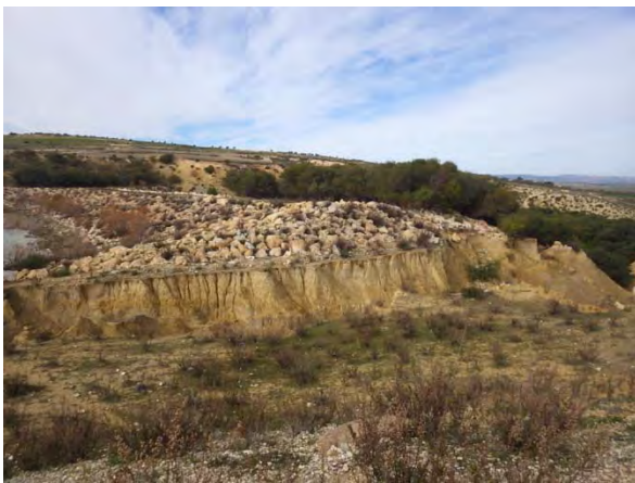
洪水吐側水路部
