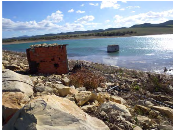
貯水池とポンプ、取水塔
