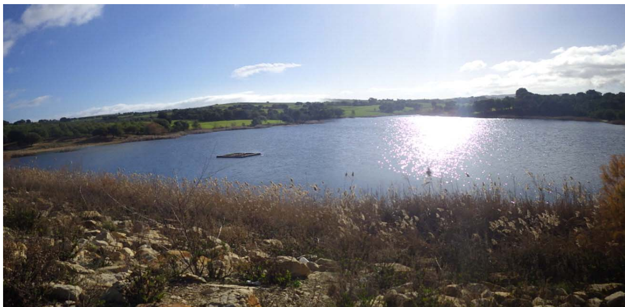
貯水池全景。中央左取水塔天端。ほぼ満水位。
