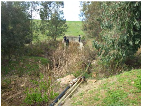
取水放流工とパイプライン
