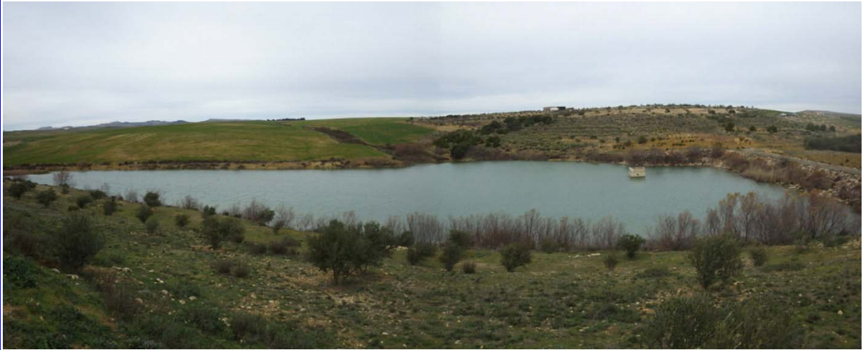
貯水池全景。写真右側に取水塔と堤体。
