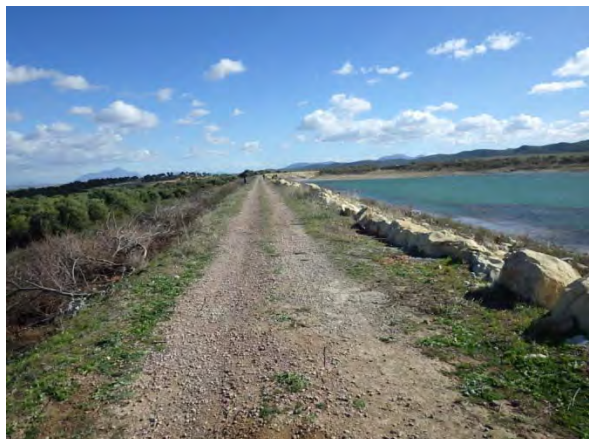
天端左岸側から右岸側を望む
