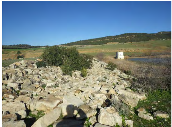
堤体上流面及び取水塔
