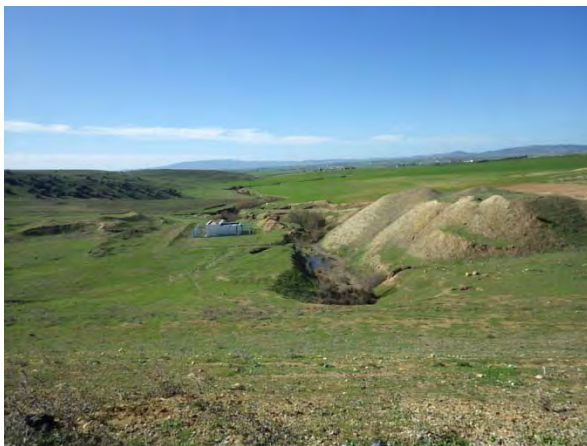
揚水ポンプ場とダム下流部
