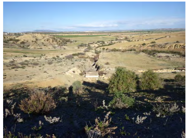
取水放流工及びダム下流側
