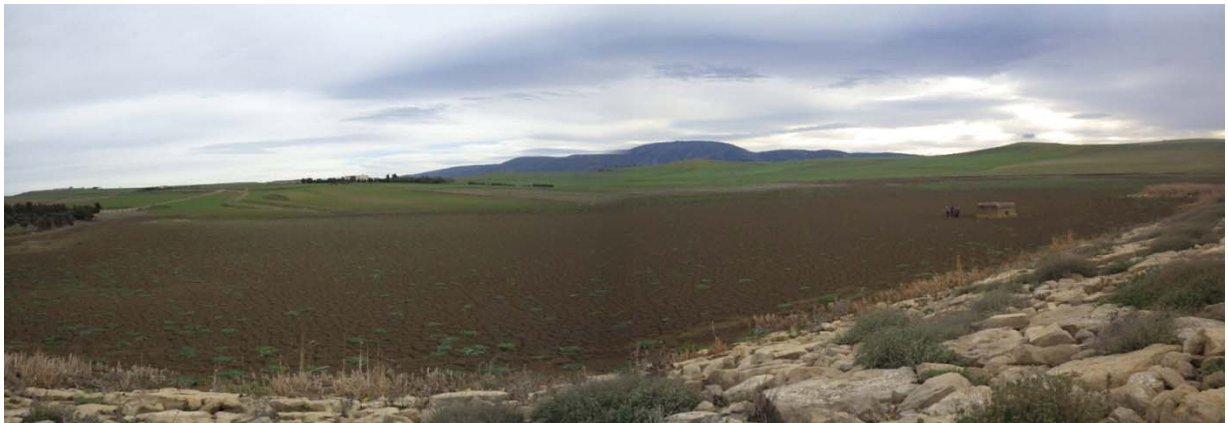
右岸側から貯水池及び取水塔。土砂堆積が進行していて、貯水はない。
