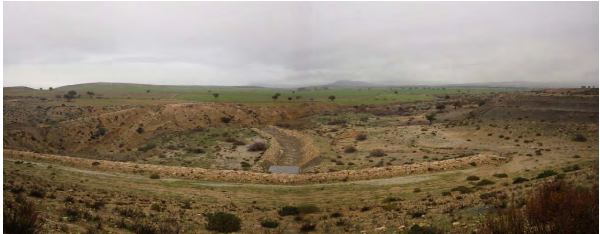
取水放流工とダム下流部全景
