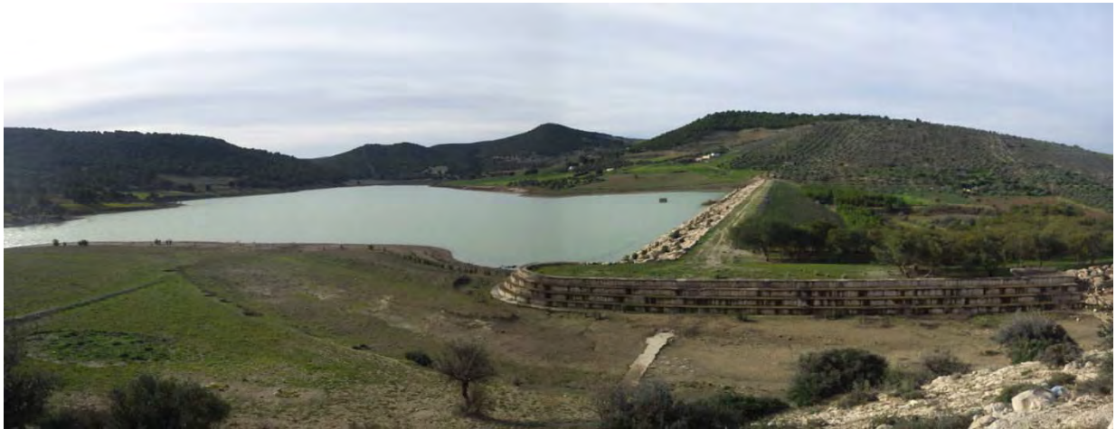
右岸側からダム全景。手前に洪水吐流入部
