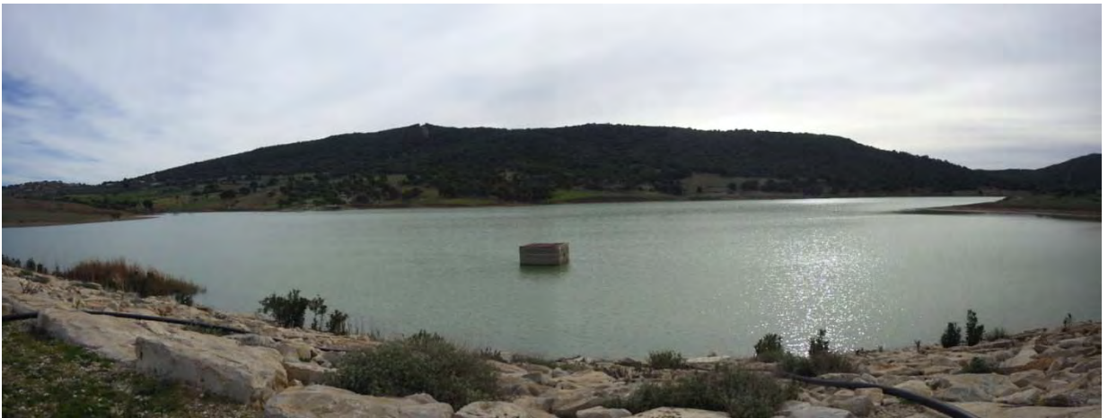
貯水池全景と取水塔。サインフォン方式のパイプ
