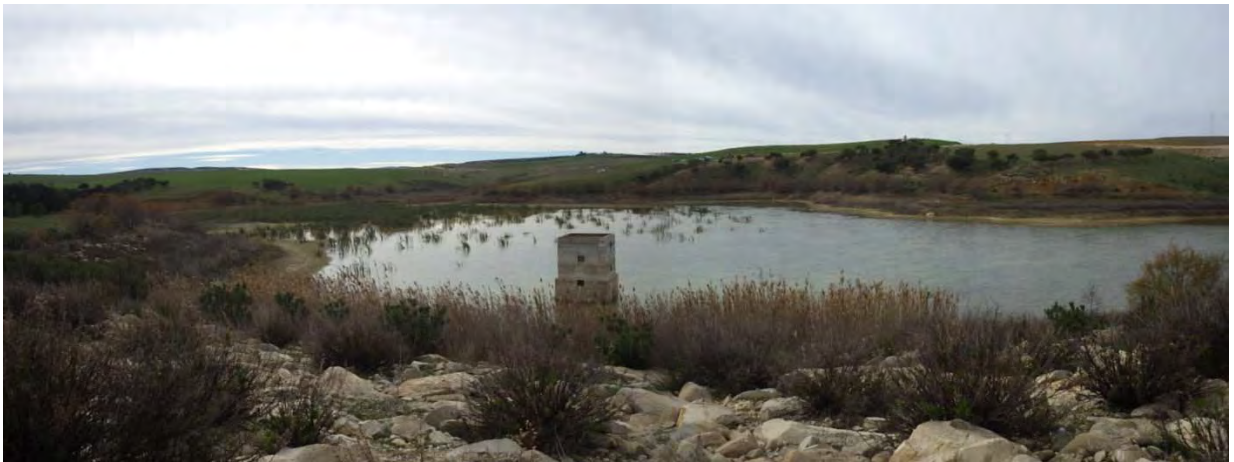
貯水池全景。中央に取水塔。水位は低い。
