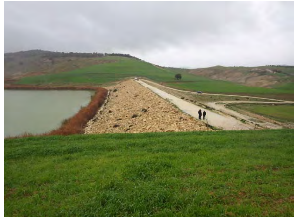
堤体右岸側から堤体上流部
