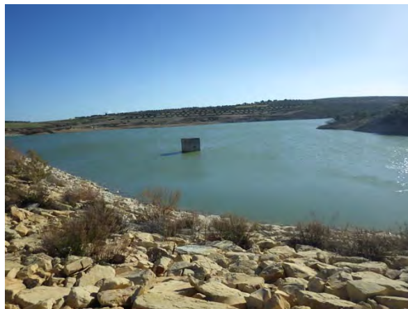
貯水池及び取水塔 貯水池周辺は土壌侵食防止対策が取られている
