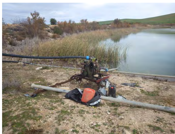
貯水池からの取水ポンプ
