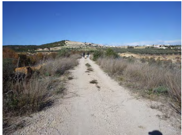
堤体天端右岸側から左岸側を望む
