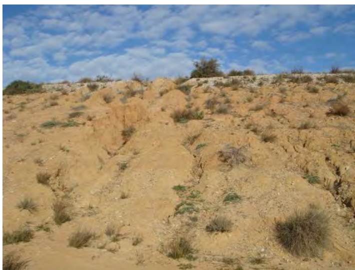
図 6.1 SO-1 Breck の堤体下流法面が 雨水浸食されている様子
