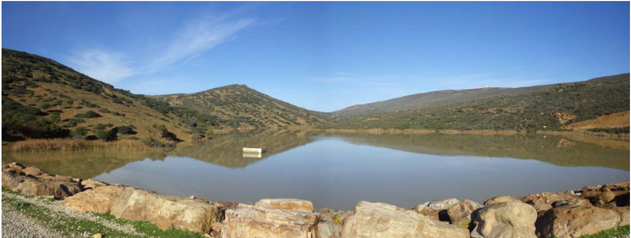
貯水池全景。中央左に取水塔。
