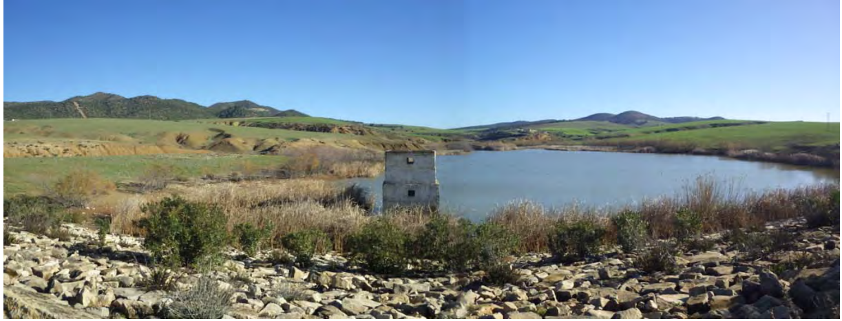
貯水池全景。中央に取水塔。貯水位は低い。
