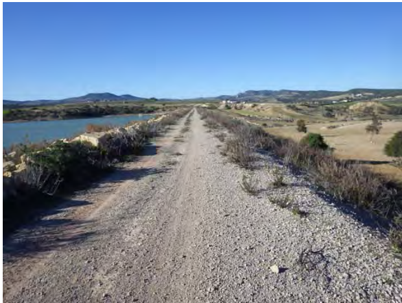
堤体天端右岸側から左岸側を望む
