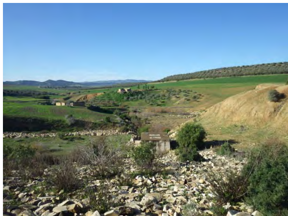
ダム下流部及び取水放流工
