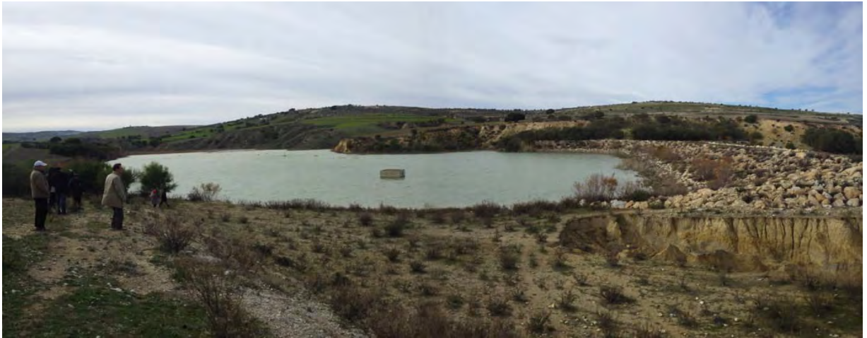
貯水池全景、中央取水塔、右側に堤体。手前激しく侵食された洪水吐流入部
