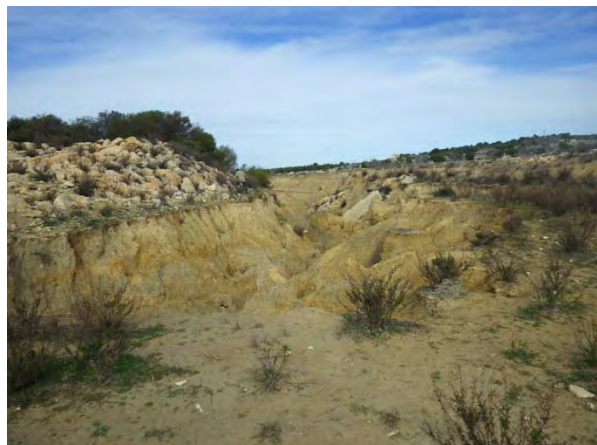
洪水吐急流部
