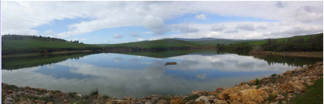
貯水池全景。中央に取水塔頂部。
