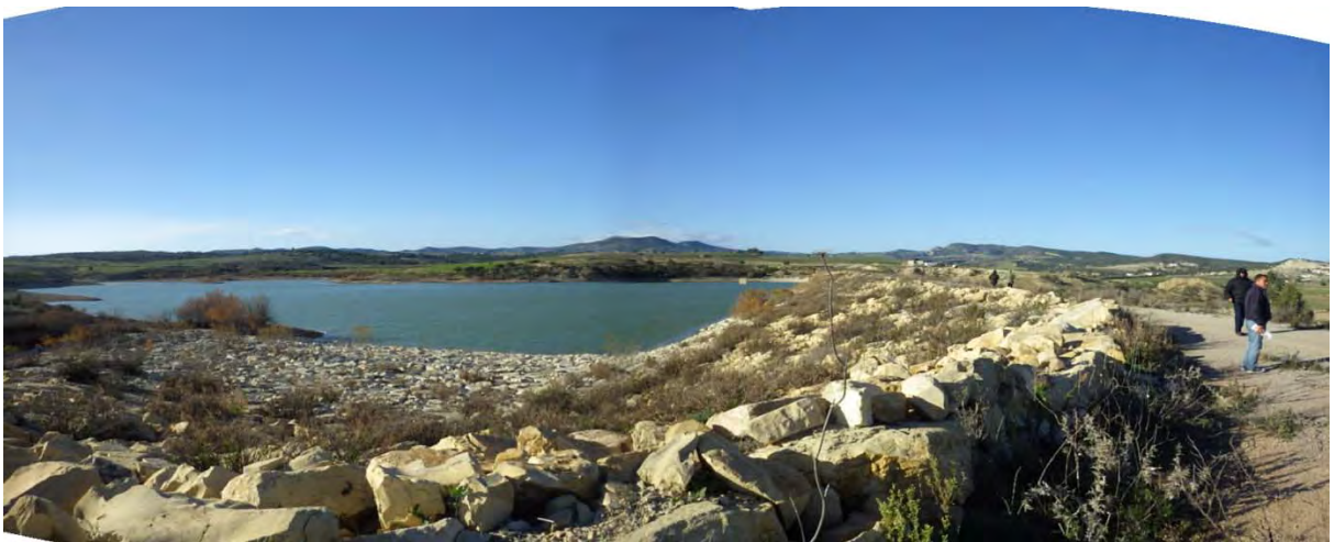
右岸側からダム上流面及び貯水池
