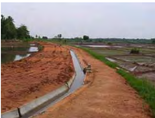
ラジャンガナ地区 整備された灌漑水路及び農道
