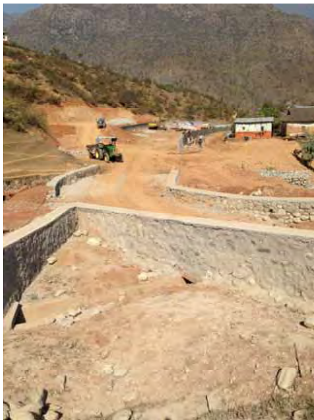
ラマタール管理事務所建設地
