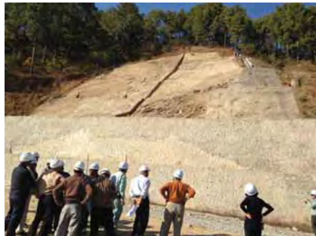
パイロット事業対象地（斜面对策工）
