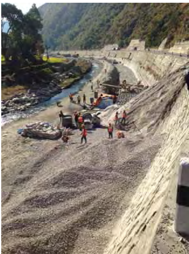
パイロット事業対象地（川床工）
