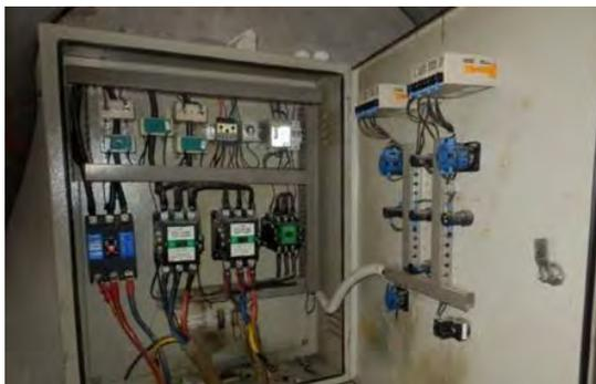
写真-6：ラジコットポンプ起動盤
