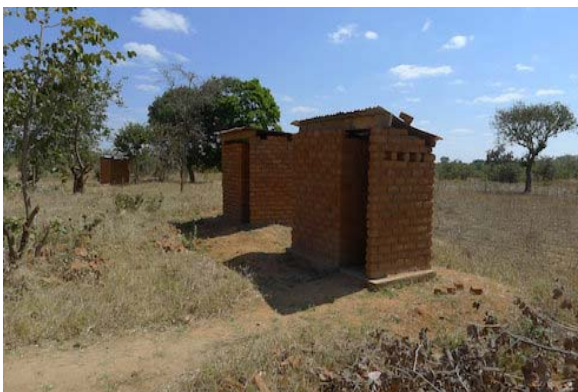
R6 Mzoma CDSS 既存肥溜め式便所。
