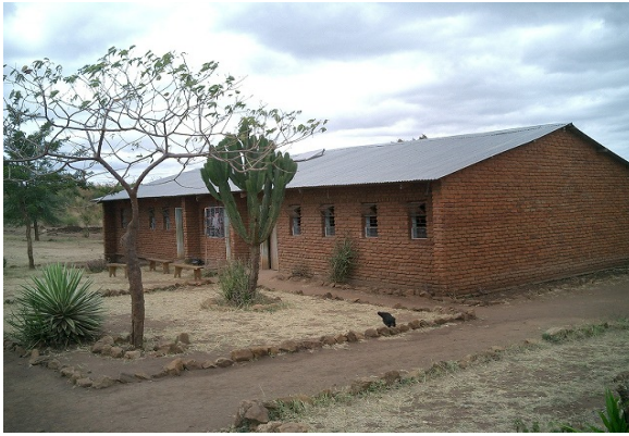
R4 Kabekere CDSS 2005年 コミュニティにより建設。
