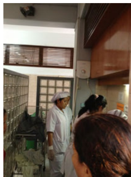
給湯箇所の電気温水器
