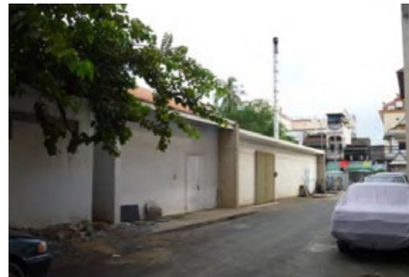
G 2001年に我が国の技術協力により改修された焼却炉/倉庫棟
