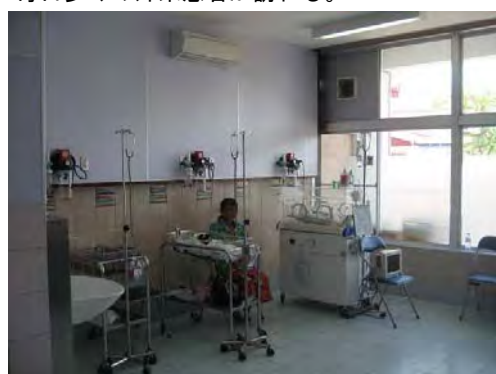
北棟2階NCU 現在のNCU内部。
