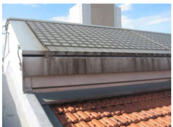
トップライトガラスブロックの状況
