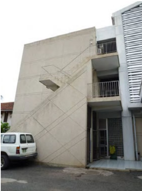
C 新研修棟と接続地点となる南棟階段室
