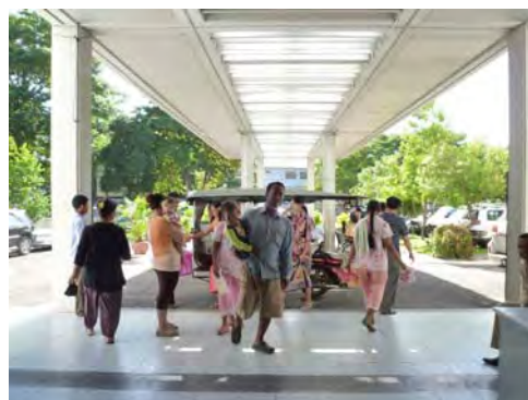
既存センター南棟 既存センター南棟1階外来部門へのアクセス状況。
