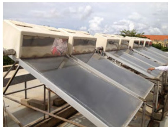
太陽熱給湯器設置状況
