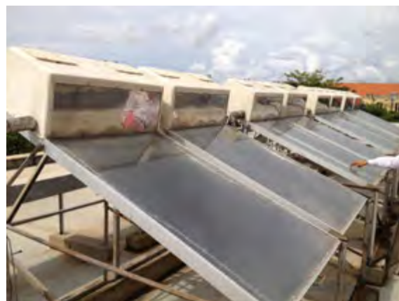
太陽熱給湯器設置状況
