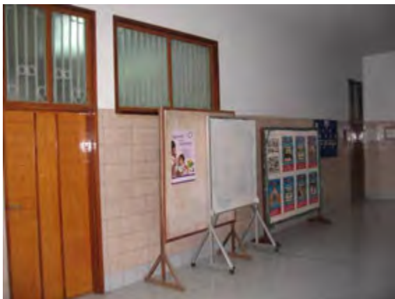
ラウンジ部に壁を設置して事務室とした部分
