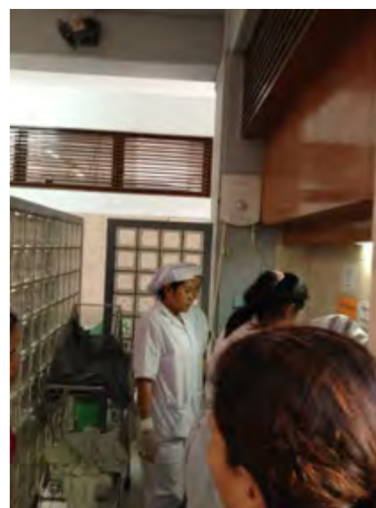
給湯箇所の電気温水器
