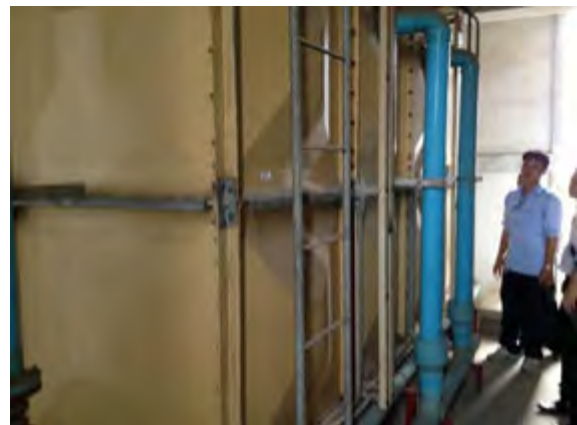
高架水槽状況
