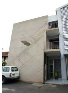
既存南棟階段 新研修棟と接続地点となる南棟階段室。
