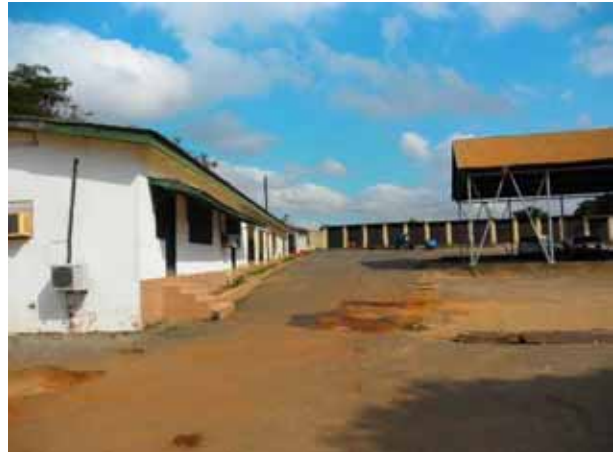
写真-2 AESDの敷地
