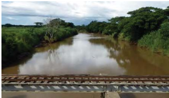
③ 1 ナワカ川橋梁箇所（洪水前） （ナワカ川：約 1km 地点）
