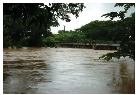
写真-8 ナンディ川（橋梁箇所）／洪水時
