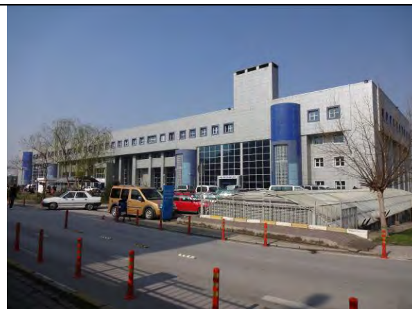
117. セブケット病院本館 : 2002年建設の本館。構造的に必要な耐震基準は満たしている。ブルサ県でA1ランクに指定されている2つの公立病院のうちのひとつである。
