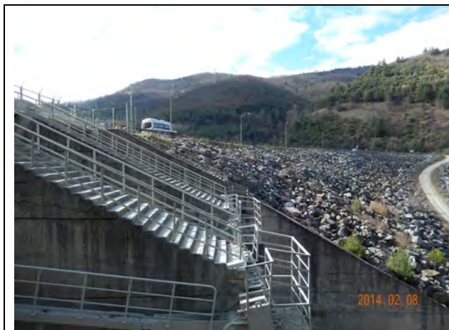
60. ドガジダム：下流側から撮影 ロックフィルダムであり、全長は約 100m である。
