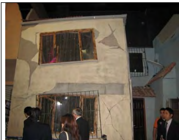
81. 82. 再現された大地震後の町並み
