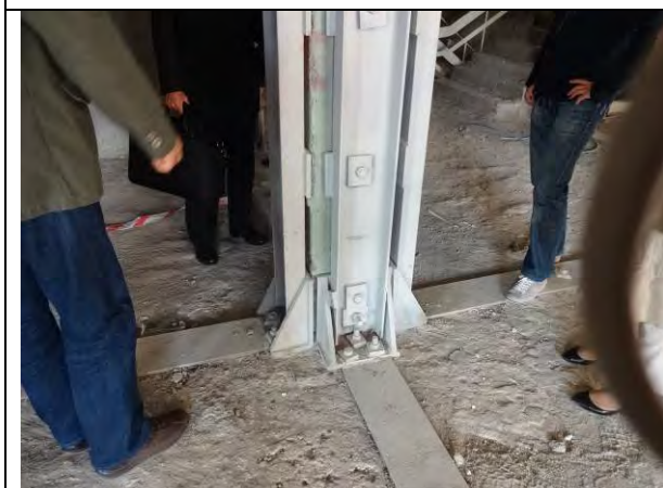
101. ハジュテペ大学病院の耐震改修：耐震改修中の病院の建物。鉄筋コンクリートの柱を鉄骨で補強している。
