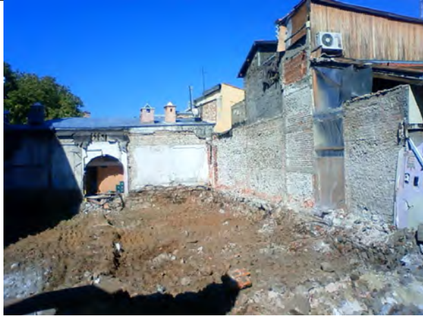
17. オールドタウンの繁華街 (5) : 老朽建物が取り壊されて更地状態になった宅地。隣接していた建物の構造が見える。(オスマンガジ区)
