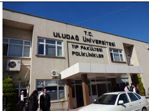
129. ウルダグ大学病院外来棟入口：公立病院として唯一世界水準の医療施設評価機構である JCI (Joint Commission International) の認定を受けている。
