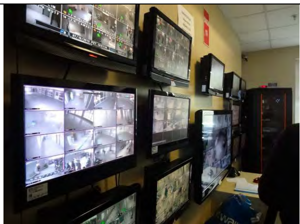
125. セブケット病院のセキュリティー管理室：マルチスクリーンモニターで病院内各所の状況を管理している。
