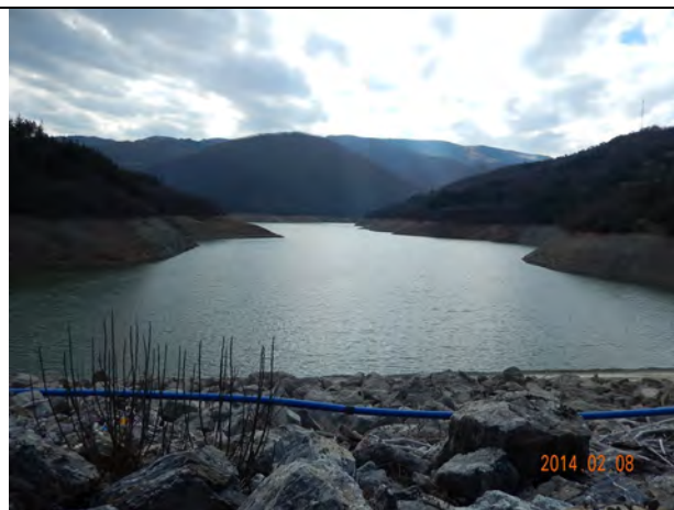
61. ドガジダム：上面から見た上流側の様子。 水位がかなり下がったことが確認できる。このダムからはブルサの水道水を供給する。
