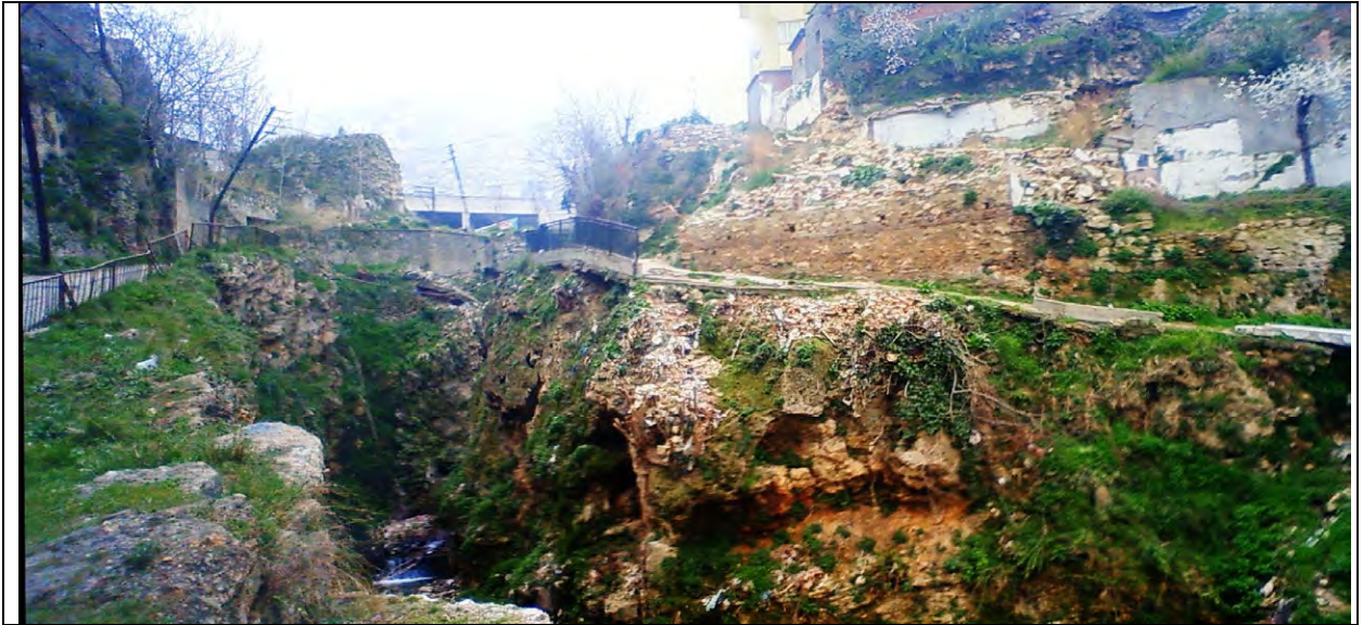
30. ウルダール山からブルサ中心部へ流れる河川：河川は溪谷状に切り立っており、その上部に市街地が山に向かってせり上がっている。(オスマンガジ区)
