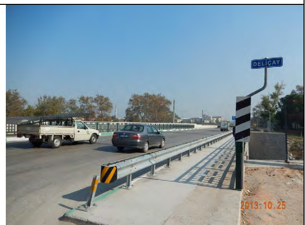
38. アンカラ-イズミル道路上にあるデリチャイ橋梁：目視では橋梁の状態は良好である。
