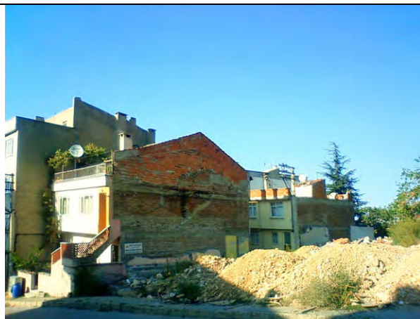
7. 老朽化した建物の構造がよく見える。床と柱は鉄筋コンクリート造だが壁はレンガ積である。新築建物にもこの構造形式が一般的に用いられている。(ユルドゥリム区)
