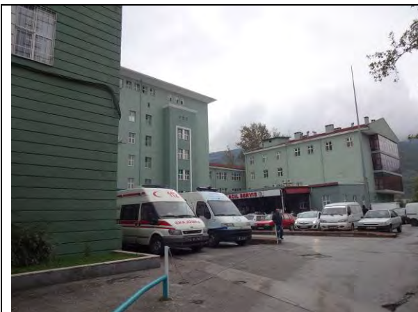
115. ブルサ・パブリック病院 (Bursa Devlet Hospital) : ドイツの設計で、1952年に建設されたがメインビルディングは耐震診断では問題ないとされている。外来棟、救急病棟、ポリクリニックの建屋は耐震補強が必要で改修する予定となっている。
