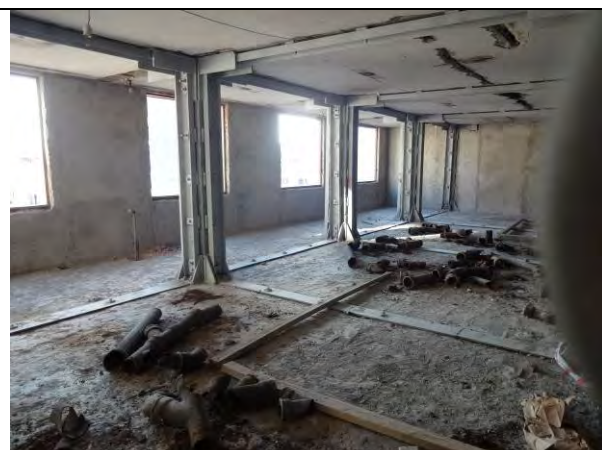
102. ハジュテペ大学病院の耐震改修：耐震改修中の病院の一部
