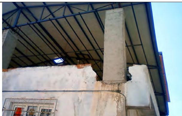
11. リスキーエリアに指定されている密集市街地内の建物の増築：増築資金に応じて上層階に増築する。建物の構造は柱と床が鉄筋コンクリート造で、壁が軽層ブロックによる組積造になっている。（ユルドゥリム区）
