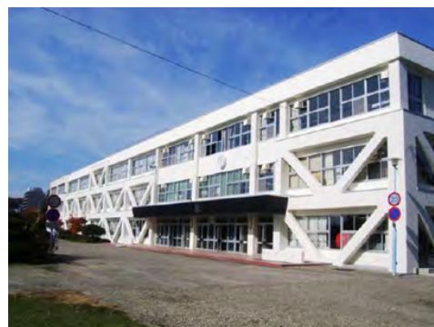
図 4.5.10 ピタゴラム工法
