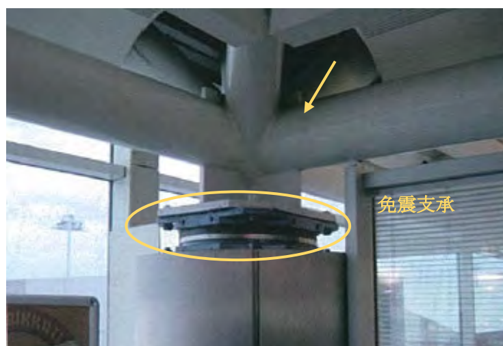
図 5.2.2 イスタンブール・アタチュルク空港の柱頭免震装置
