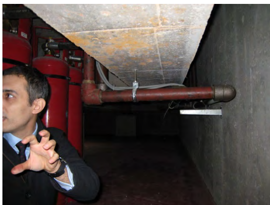
図 5.2.5 免震層の水平変位によって容易に破損する配管等
