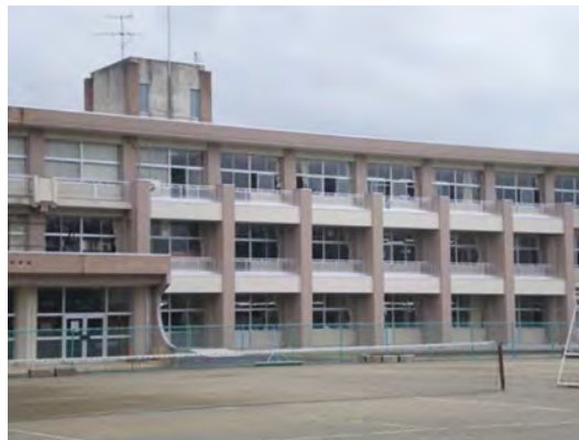
図 4.5.8 プレキャスト・プレストレスト外付けフレーム耐震補強工法
