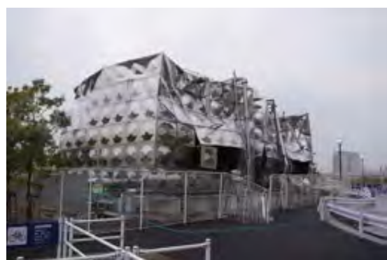
図 4.4.29 受水槽のパネルが変形
