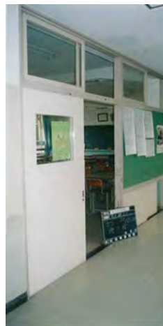
図 4.5.9 プレキャスト増設壁工法
