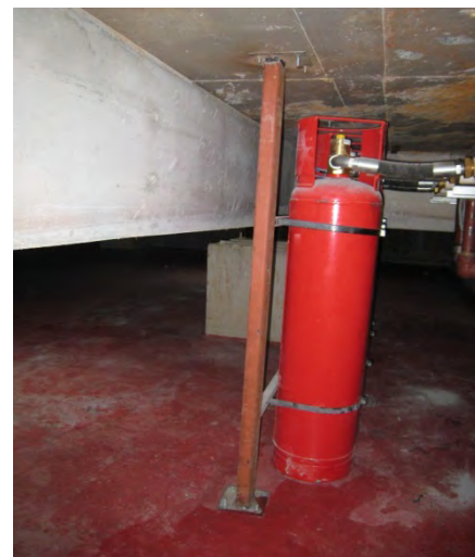
図 5.2.5 免震層の水平変位によって容易に破損する配管等
