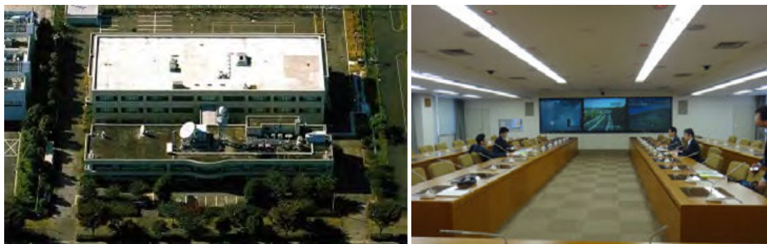
図 3.3.4 立川広域防災基地 災害対策本部予備施設
