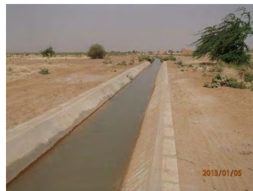
Revêtement intérieur du canal principal de Ngane.
