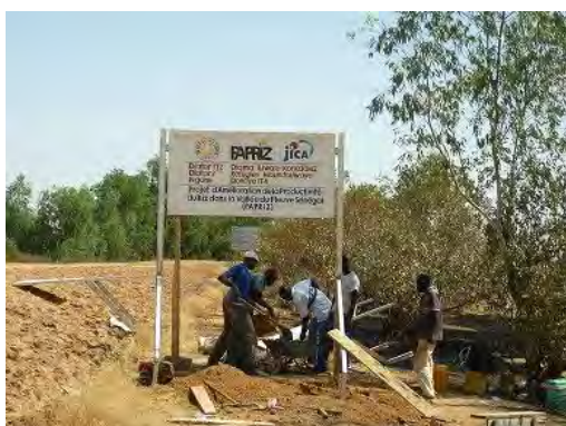
Travaux d'installation des panneaux d'affichage indiquant les zones d'intervention du projet où le PAPRIZ effectue la réfection des infrastructures d'irrigation. Novembre 2011 (Podor)
