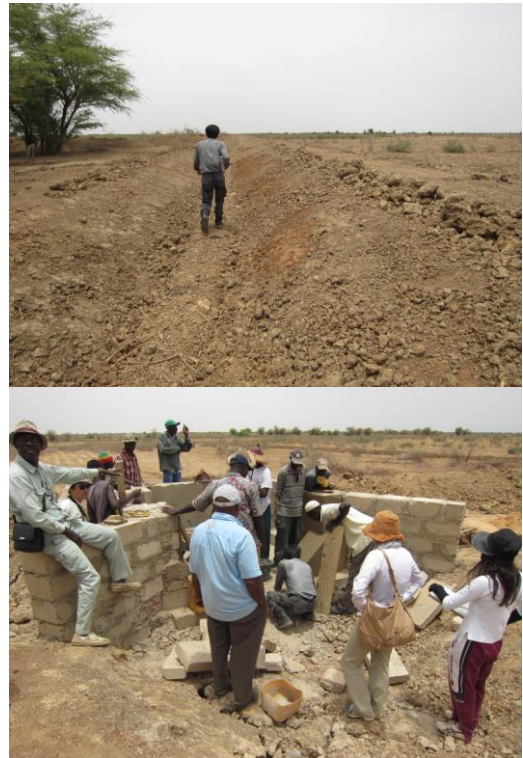
図 3.3.3 Donaye IT4 地区 (水路および分水工の補修)
