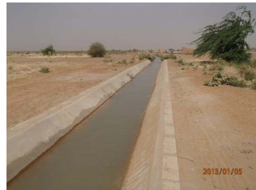
幹線水路のライニング工事。 2013年1月 (Podor, Ngane 地区)
