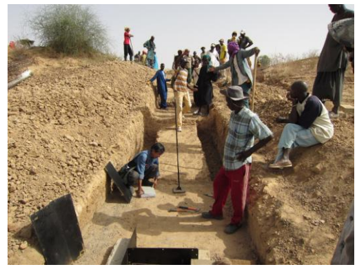
図 3.3.5 Refugies Moundouwaye 地区 (埋設パイプの更新と分水工補修)
