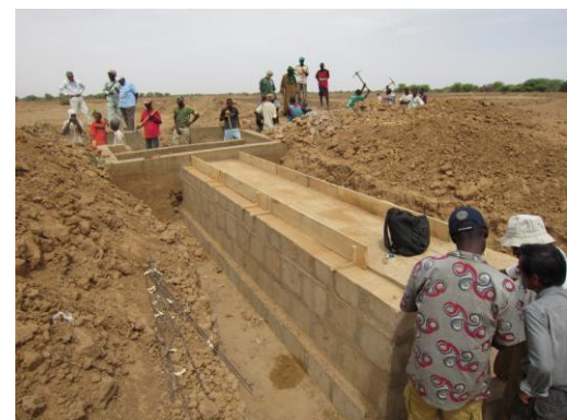
図 3.3.4 Dama Alway & Korkadie 2 地区 (分水工の補修)
