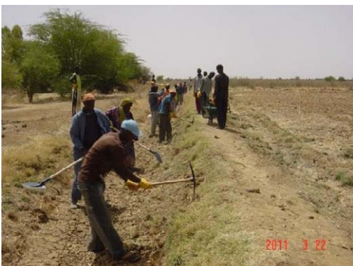
農民の参加による、既存水路の補修工事。 2011年3月 (Podor, Donaye IT4 地区)
