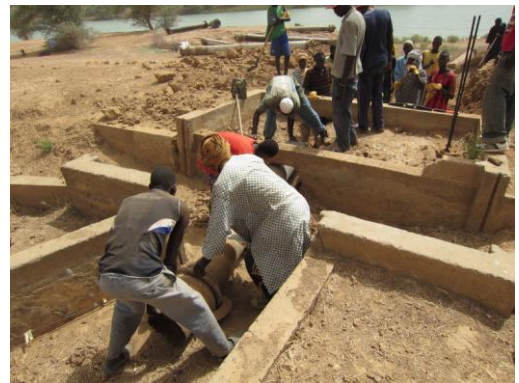
図 3.3.3 Donaye IT4 地区 (水路および分水工の補修)
