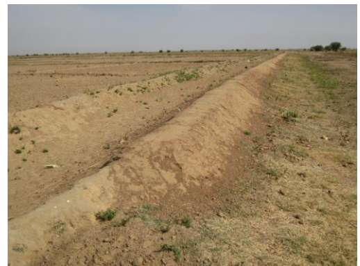
図 3.3.6 Ngane Village 地区 (ポンプ据付フロアの新設と盛土水路補修)
