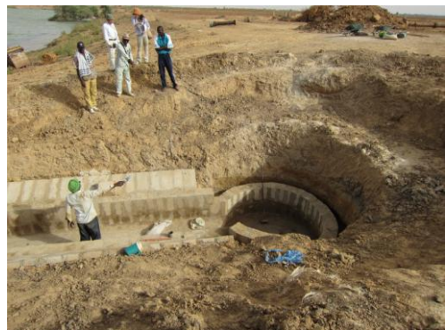
図 3.3.2 Diatar 2 地区 (ポンプ吸込ピットの新設)
