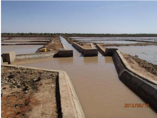
農民の参加による、分水工工事。 2012年3月 (Podor, Diatar2 地区)
