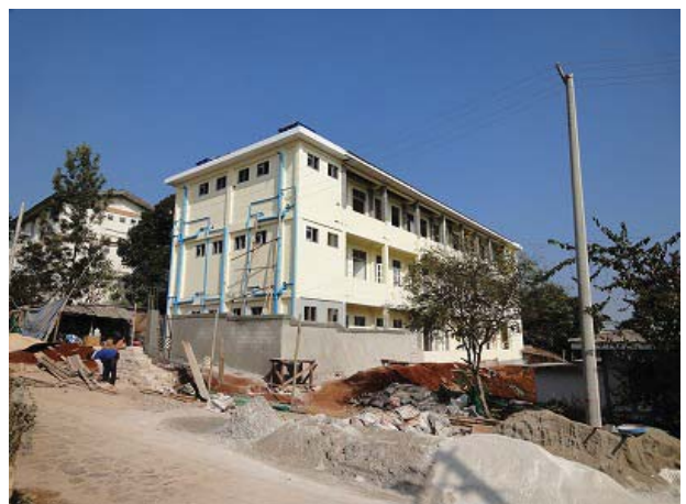
No.36 病院敷地内に建設中の看護学校学生寮
