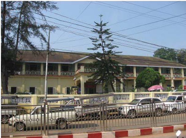
No.1 外来/救急・検査・血液銀行棟。市中心の大通りに面する。 本館(南館)建設予定地
