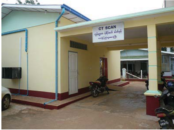
No.31 CTスキャン室棟外観
