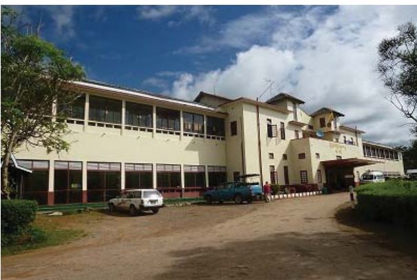
No.5 本館外観
