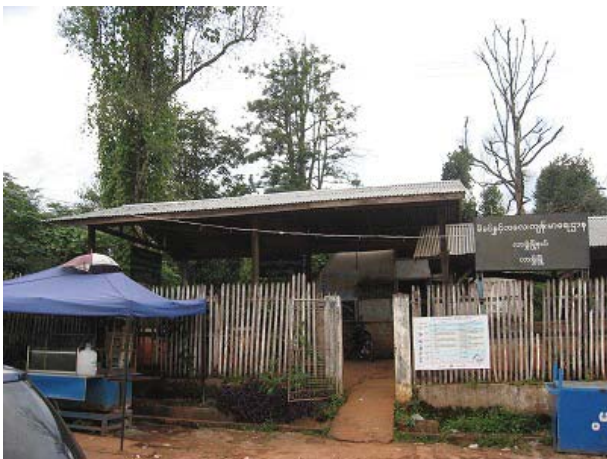
No.3 母子保健事務所 本館(北館)建設予定地
