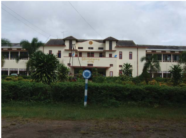
No.1 病院正面入口より病院本館正面を見る。手前が車廻しの庭
