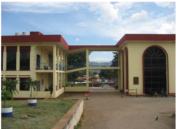
No.18 渡り廊下。外科・整形外科病棟、手術・分娩棟、産婦人科病棟、小児科病棟は2階レベルで繋がっている。
