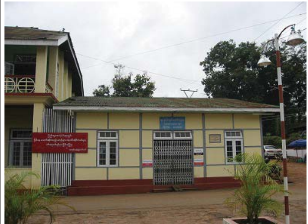
No.2 歯科診療棟。外来/救急棟に隣接。 本館(南館)建設予定地
