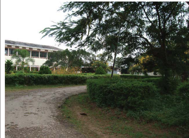
No.4 東棟建設予定地。左側が玄関前の庭。その奥が本館。
