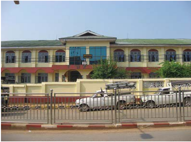
No.13 外科・整形外科病棟外観
