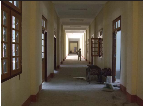
No.20 1階廊下(両側に病室)
