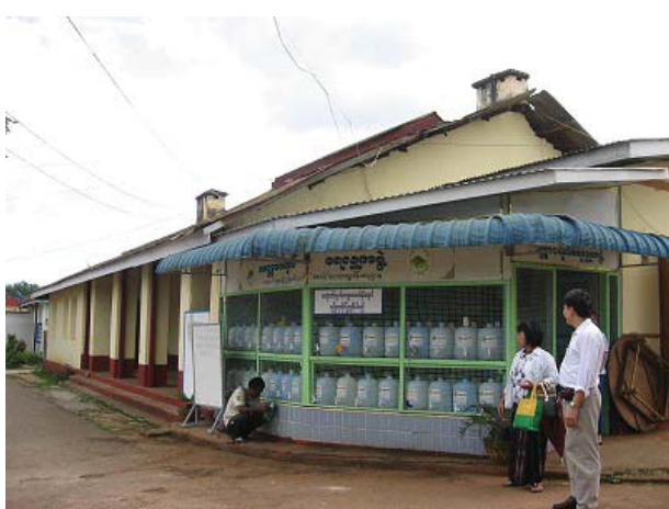
No.33 旧ミャンマー医療協会(MMA)事務所棟 飲料水の取水所
