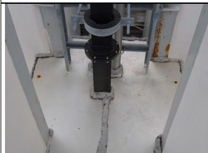
6 階レドーム室 (ケーブルダクトのカバー)
