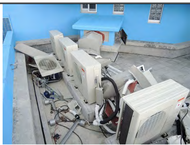
2階屋上 (エアコン室外機置場)
