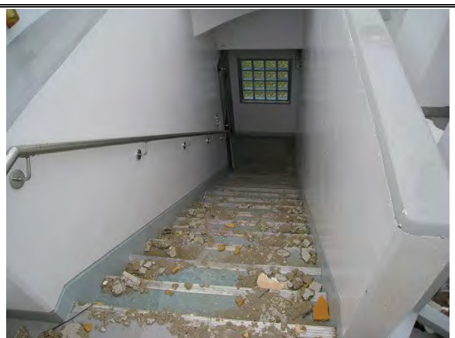
6階レドーム室 (階段)
