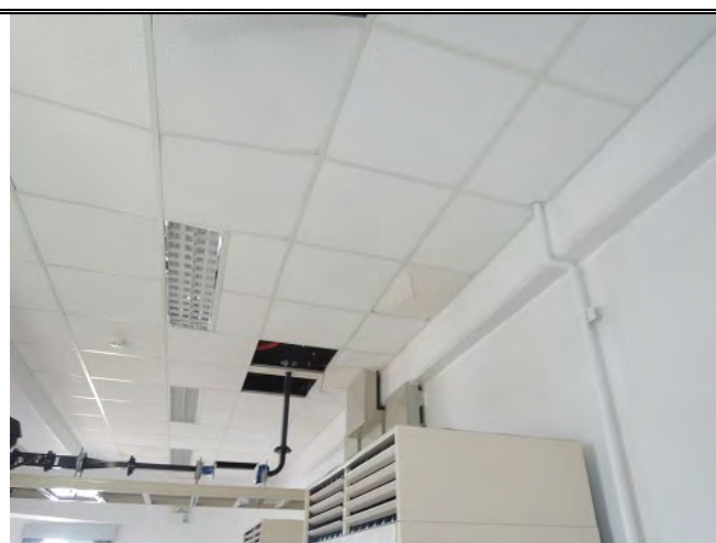
M4階レーダー機械室 (5階ケーブルダクト下部天井)
