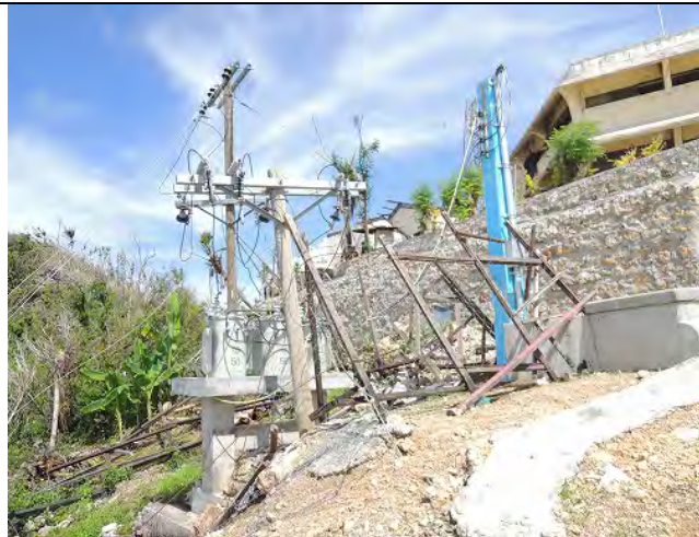
気象レーダー塔施設のための電源変圧装置
