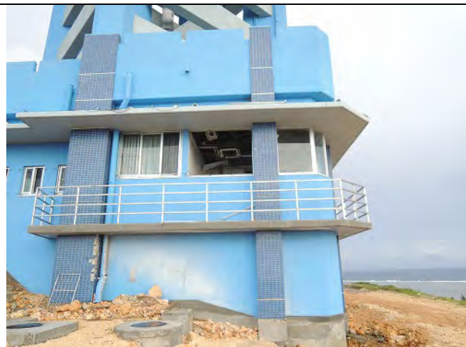
施設南側からの観測室
