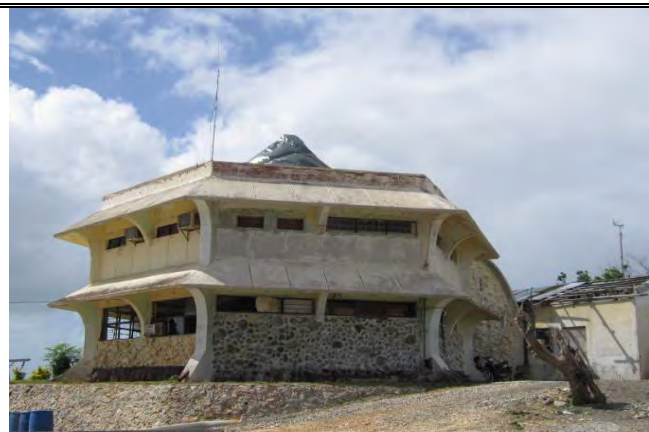
既設施設 (旧気象レーダー塔施設)
