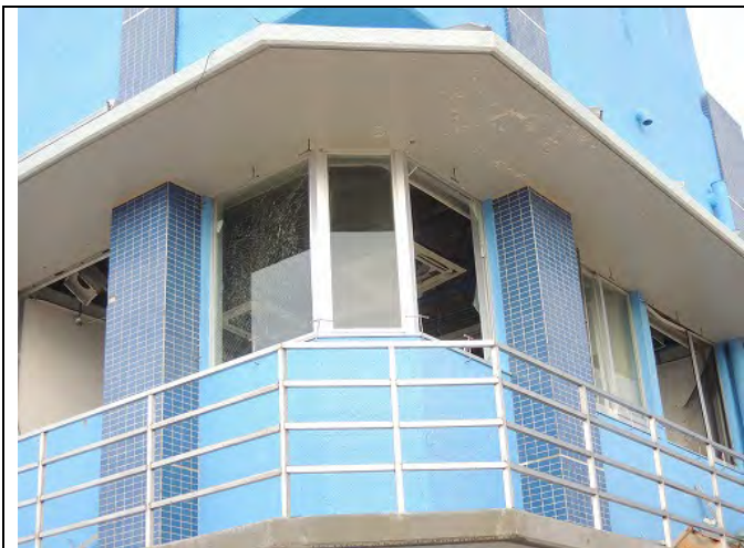
施設南東側からの観測室
