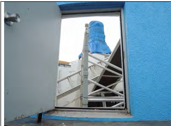
6階レドーム室
