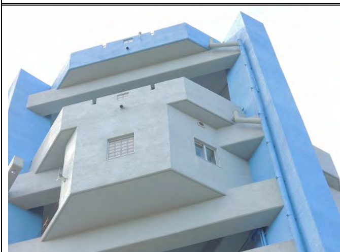
M4階レーダー機械室 (南東側外壁)
