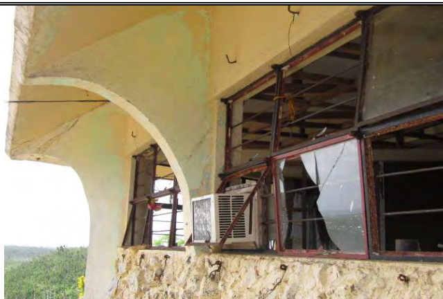
既設施設 (旧気象レーダー塔施設)
