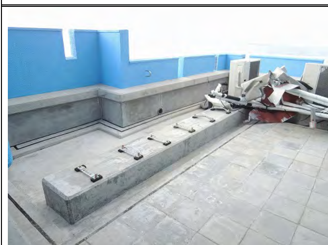
2階屋上 (エアコン室外機置場)
