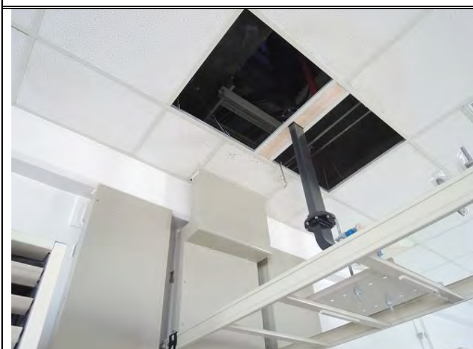
M4階レーダー機械室 (5階ケーブルダクト直下の天井)
