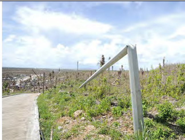
気象レーダー観測所内の電柱
