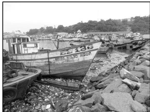
写真-3-1-2(1) 防波堤周辺に集積するゴミ
