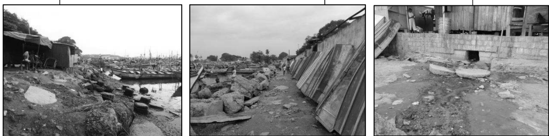
図-2-1-4-1(13) カヌー突堤～旧スリップウェイの状況写真
