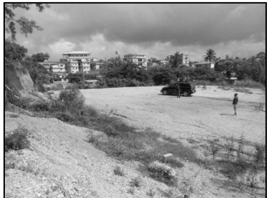
写真-51 仮設ヤードの状況
