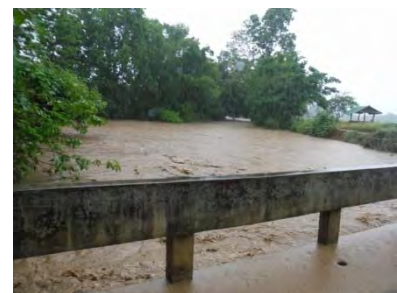
同左の橋における洪水時の状況 (2012年5月に村長撮影)
