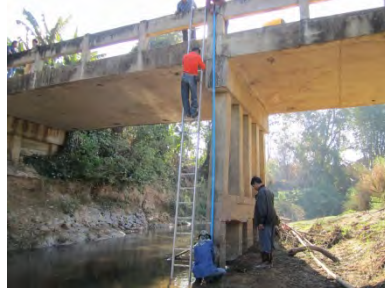
水位計の設置状況
