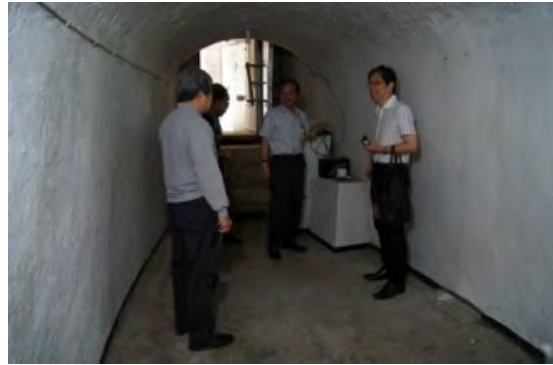
ババダン観測所の観測トンネル
