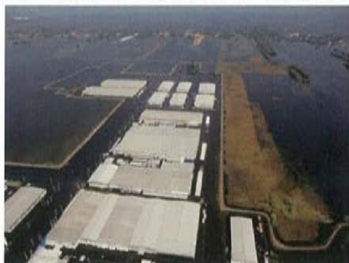
ロジャナ工業団地の一部。整備された堤防が確認できる。
