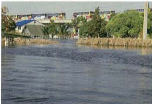
破堤箇所と高架道に避難した観光バス
