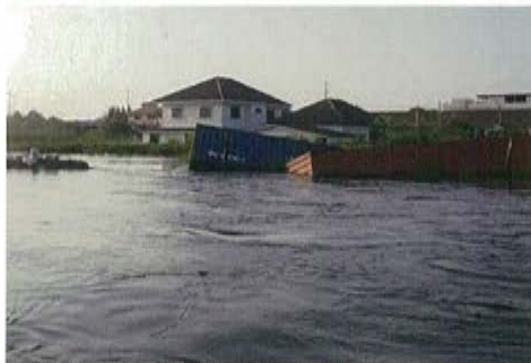
堤防破堤箇所に投下されたコンテナ
