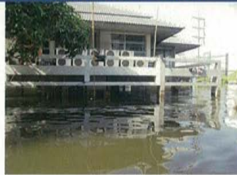
ロジャナ工業団地の事務所(1階は半分高さまで水没)
