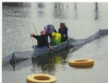
※2 ゴミ進入ネット設置・管理
