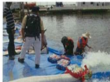
※3 堤防法面保護
