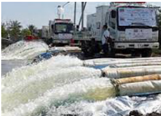
排水作業の様子
