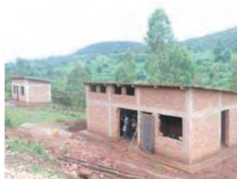
Le hangar de stockage des semences en cours de construction
