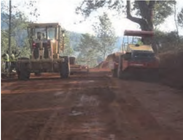
グレーダーとローラーによる建設作業の様子
