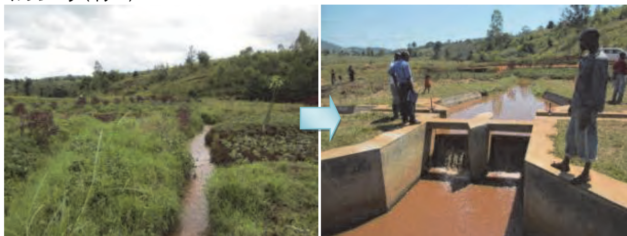
建設前の様子
