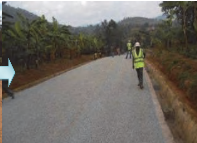
道路改修現場(改修後)
