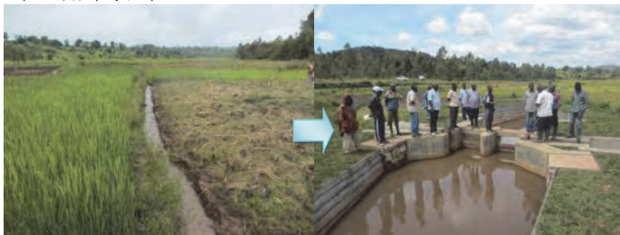
建設前の様子
