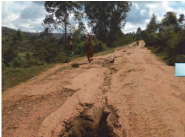
道路改修現場(改修前)
