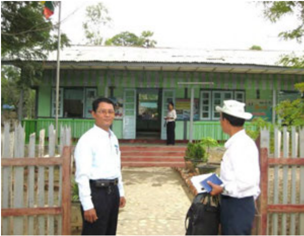
チャウスエ地方区 / 市町区事務所
